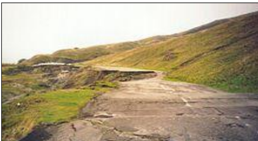
Figure I.1 : Glissement de terrain
