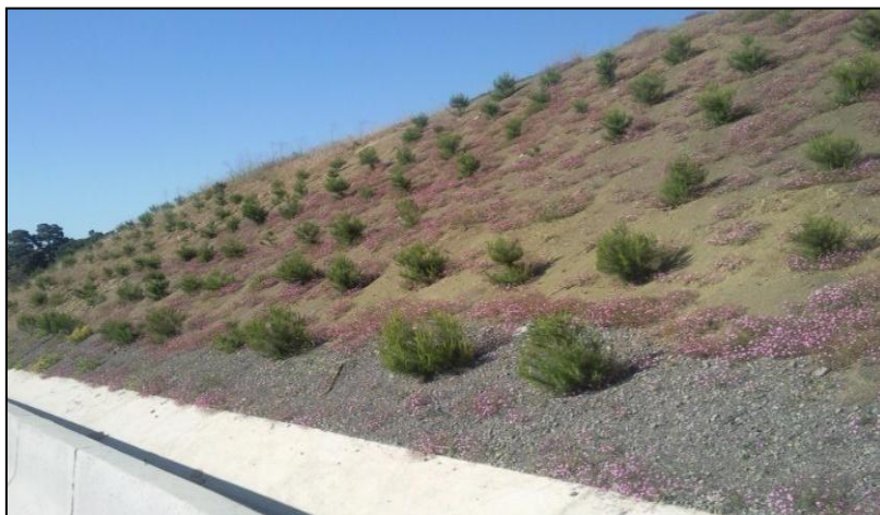
Figure I.40 : Photo d'un confortement par terrassement (Autoroute Est-Ouest)
