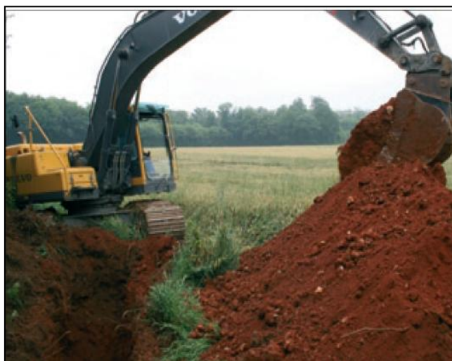
Figure I.21 :Sondages à la pelle mécanique
