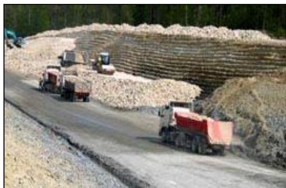
Figure I.48 : Réalisation du masque drainant
