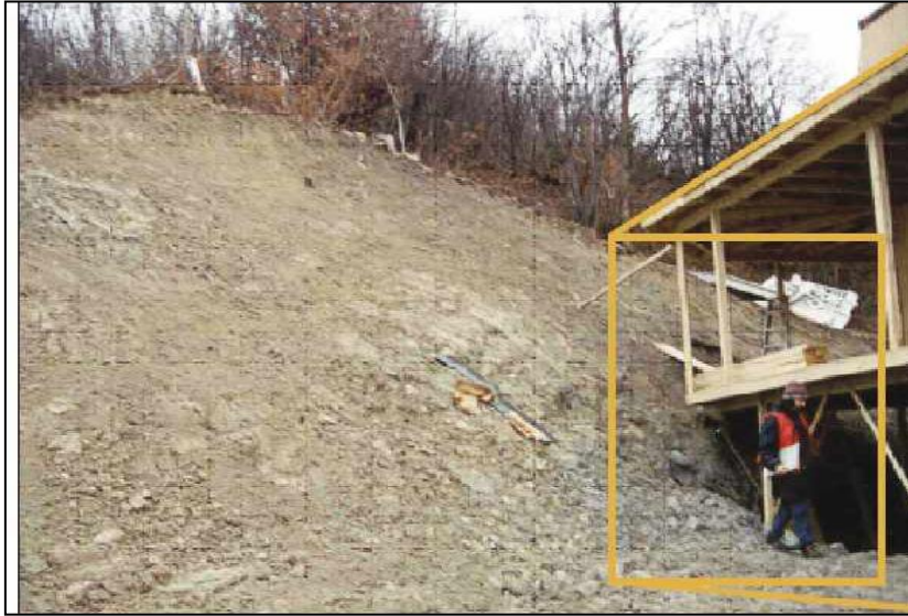
Figure I.10 : Déblai au pied du talus
