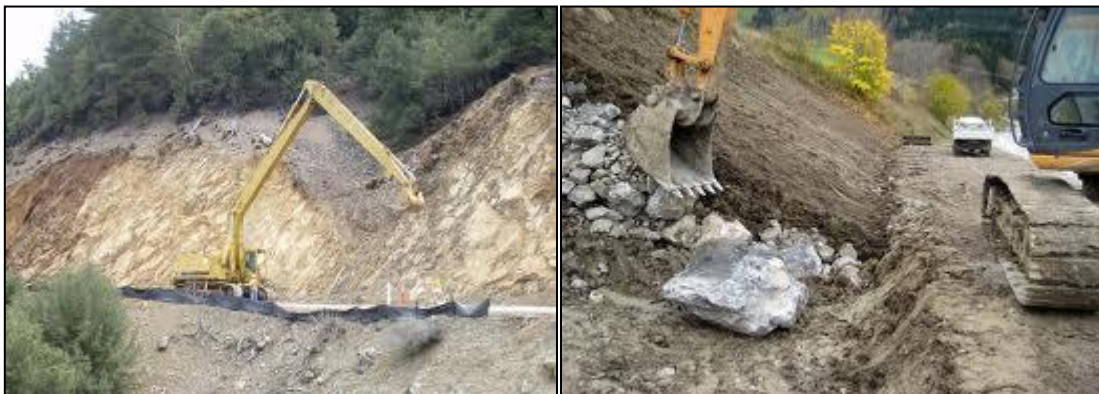
Figure I.44 : Terrassement et purge en pied
