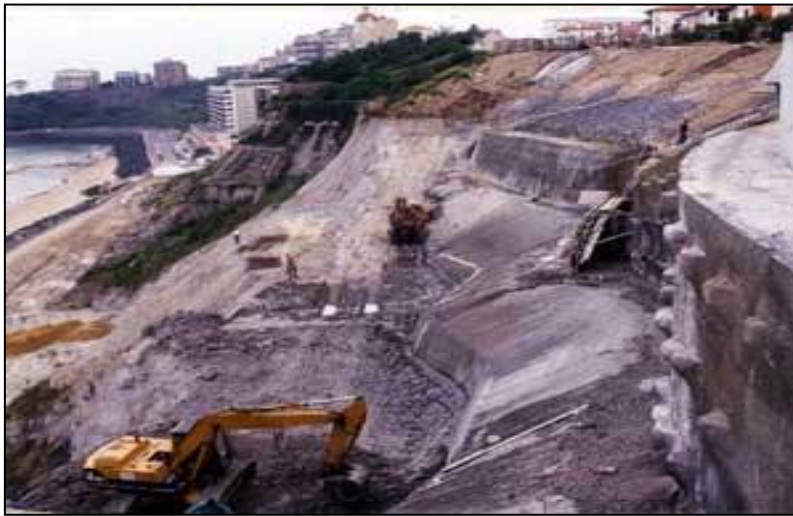
Figure I.39 : Confortement par terrassement
