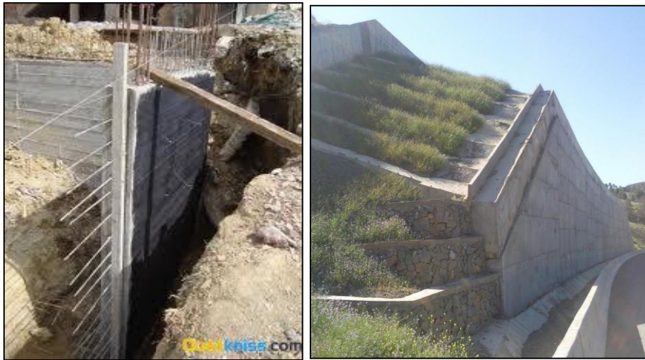
Figure I.50 :Mur de soutènement
