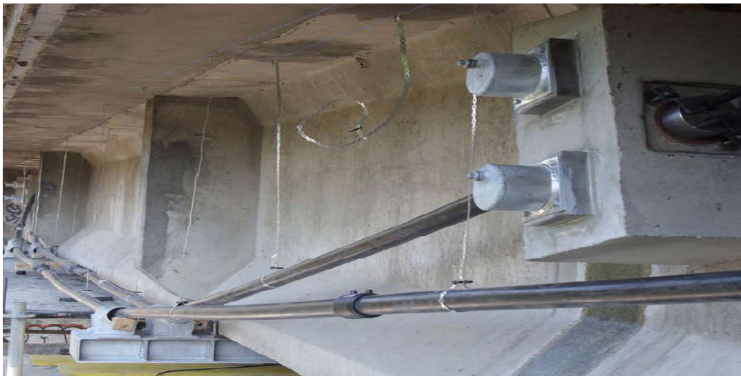
Figure 1.6. Précontrainte additionnelle d'une poutre.
