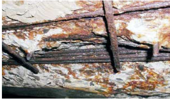
Figure 1.2. Corrosion initiée par des chlorures[4]
