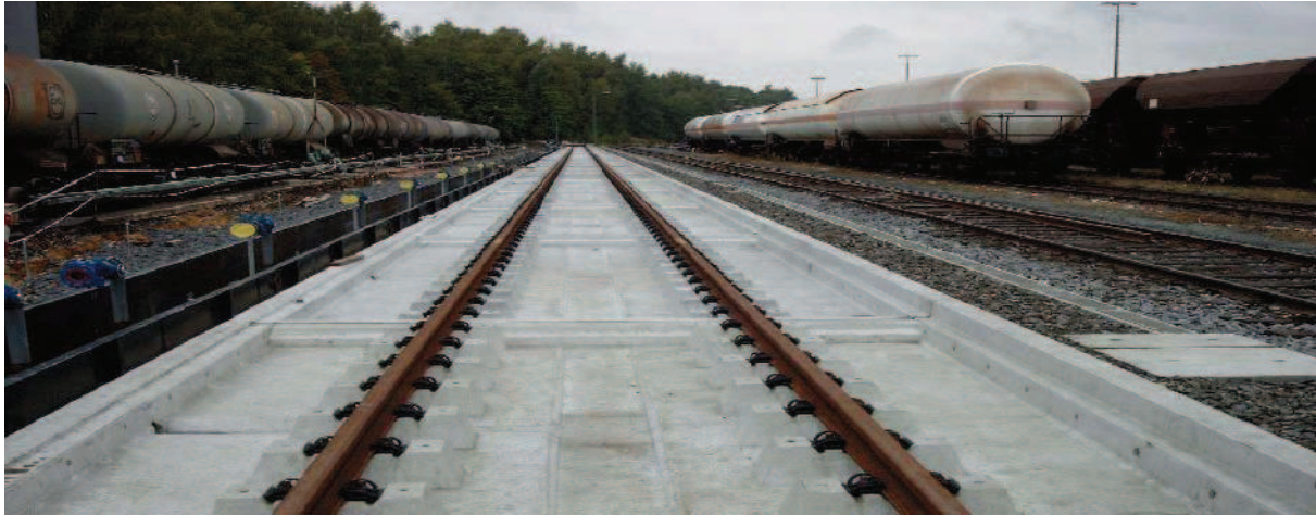
Fig. III.22 : Voie en dalle de béton (sans ballast)
