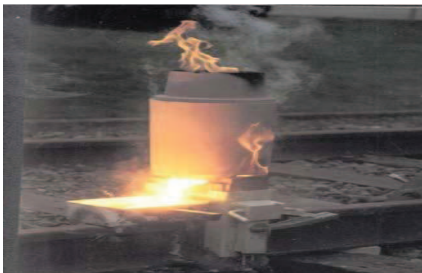
Fig. II.10 : Soudure aluminothermique de deux barres de rails soudés
