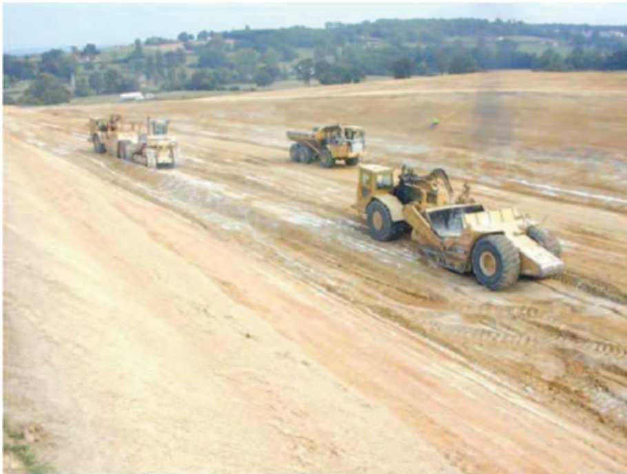
Fig. IX.5 : engin de terrassement
