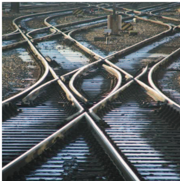
Fig.XII.01 : photo d'un appareil de voie
