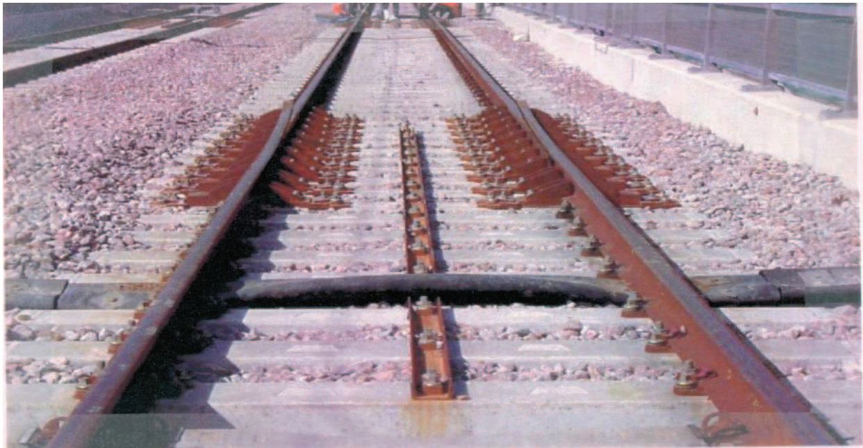
Fig.III.08 : Appareil de dilatation pour LGV
