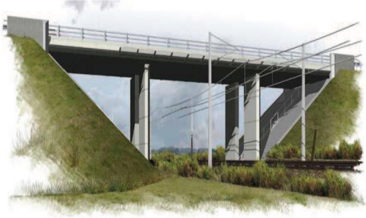
Fig.X.03 : passage inférieur d'un chemin de fer
