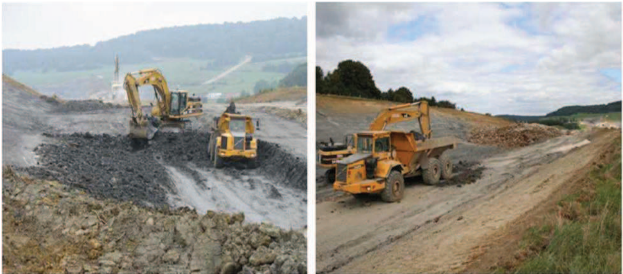
Fig. IX.4 : opération de terrassement
