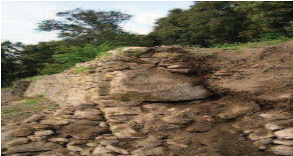
Fig.X.05 : pêrrés maçonnés dans un talus
