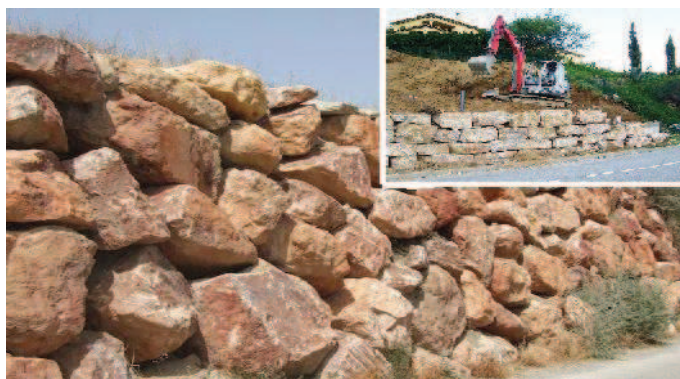
Fig.X.07 : enrochement des pieds des talus
