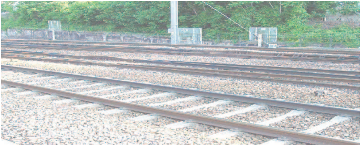
Fig.III.01 : Une voie ballastée
