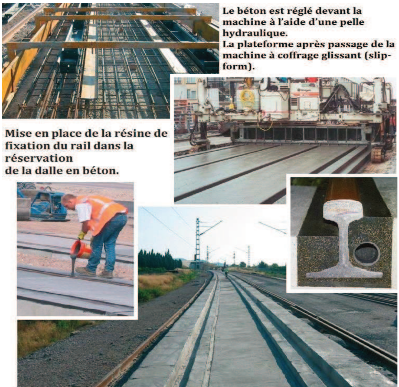
Fig.III.25 : Mise en œuvre du système d'ERS
