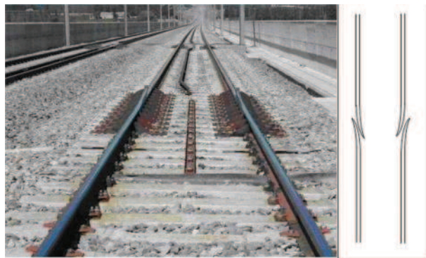
Fig. XII.09 : appareil de dilatation
