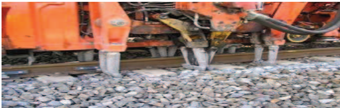
Fig. III.20 : Bourrage de ballast
