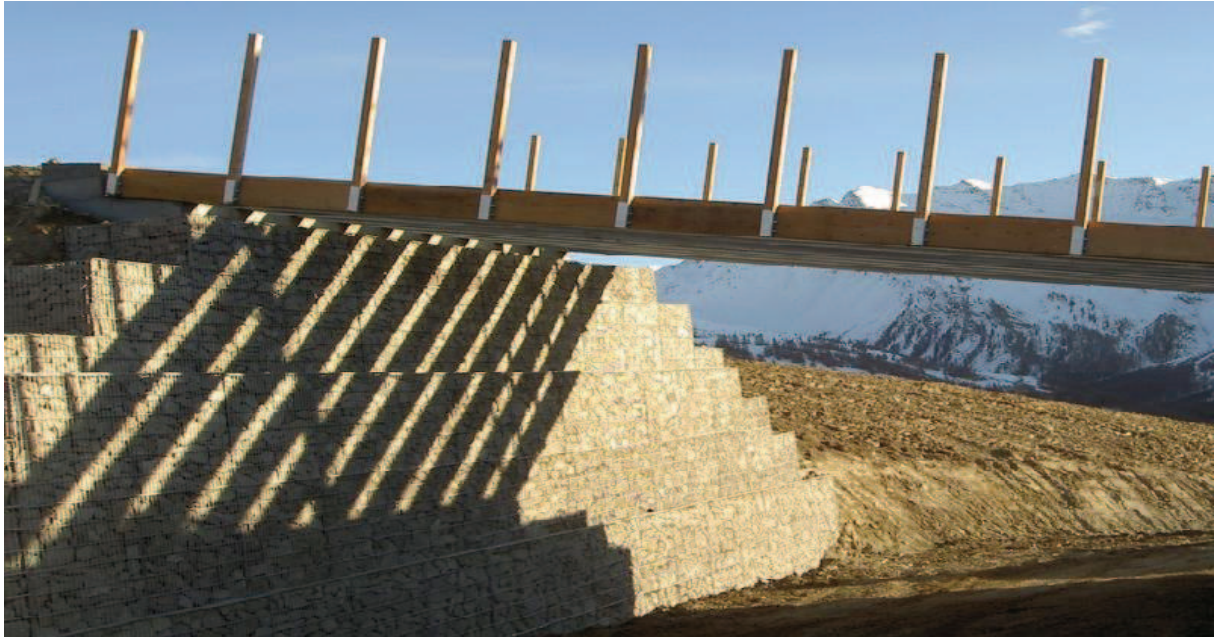
Fig.X.04 : mur de soutènement en gabio
