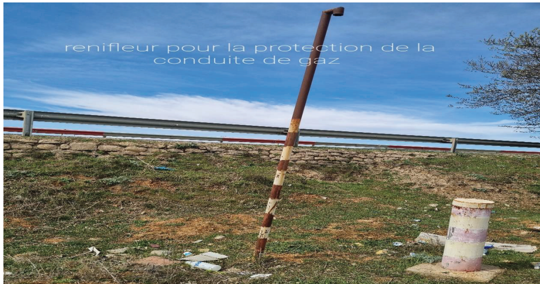
FigureXIII.8 : conduite de gaz à l'abscisse 3+400.00
