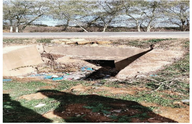
figure X.2 :OA PK 74+350 (carrefour Beni Snous)Plots Bouché et disloqué
