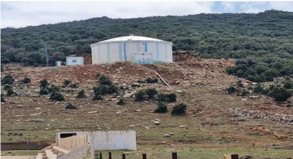
Figure IX.9 : localisation de déblai 03 sur terrain
