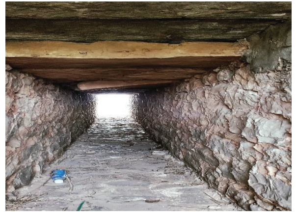
figure X.2 :OA PK 74+350 (carrefour Beni Snous)Plots Bouché et disloqué
