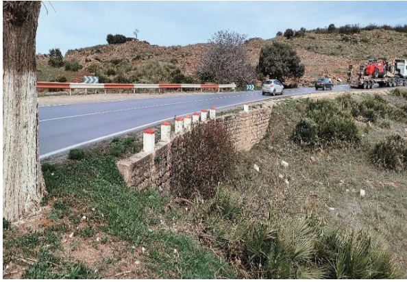
Figure X.1 : OA PK 75+795.00 – 2 X0.6 X1.2 Niveau d'eau de débordement
