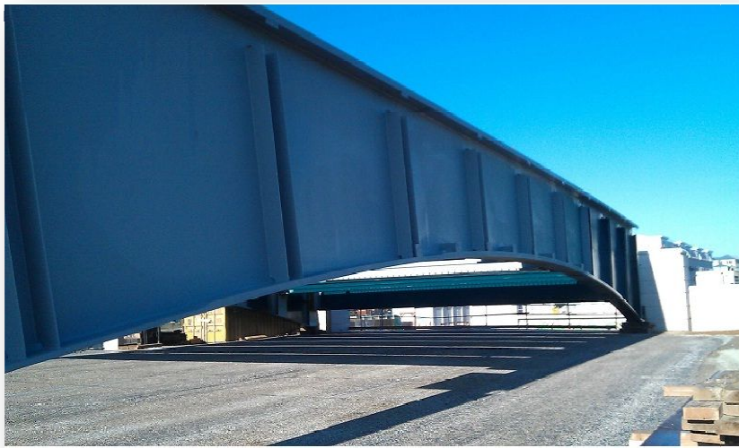
Figure 4.4 : Une poutre métallique à hauteur variable
