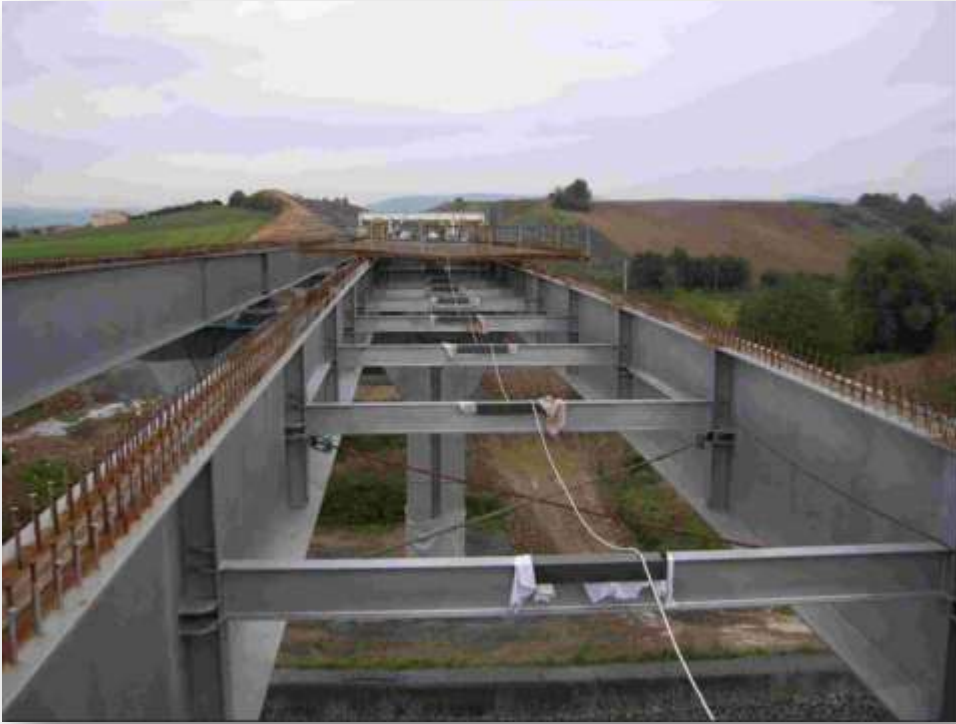
Figure 7.8: L'emplacement des connecteurs sur les poutres
