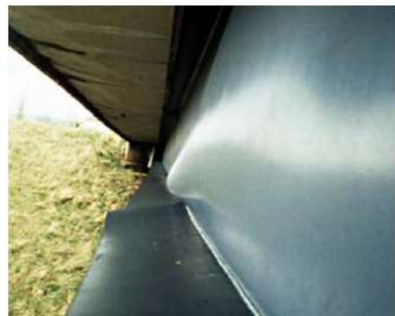
Fig.7.6.Voilement d'une plaque mince.
