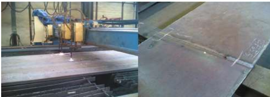
Fig.7.22.Découpage et soudage automatique des PRS (complexe SAPTA « Ruiba ; Alger »)
