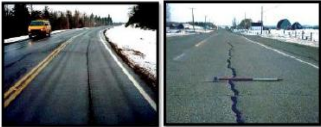
Fig.III.9: fissures longitudinales.
