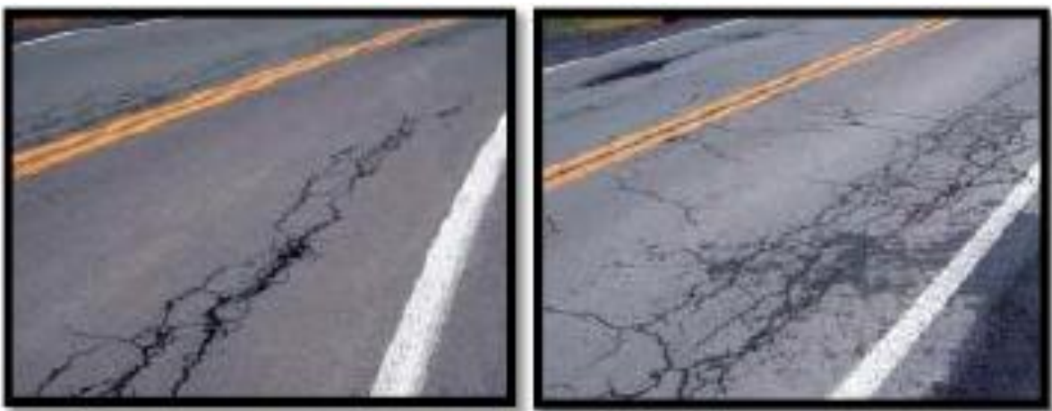
Fig.III.8: fissures en piste de roues
