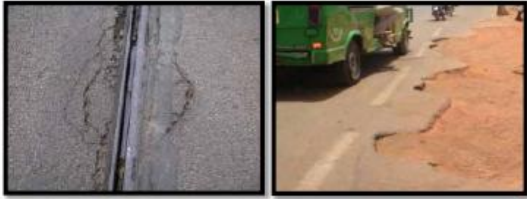
Fig.III.13: Les épaufrures
