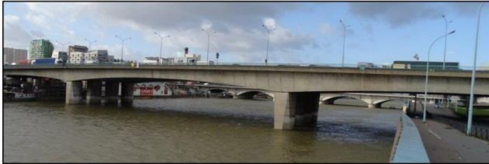
Figure II-11 : Pont voussoir en béton précontraint
