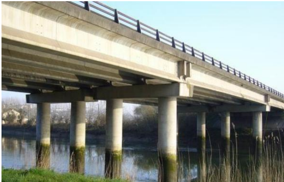
Figure II-1 : Pont à poutres précontraintes (VIPP)
