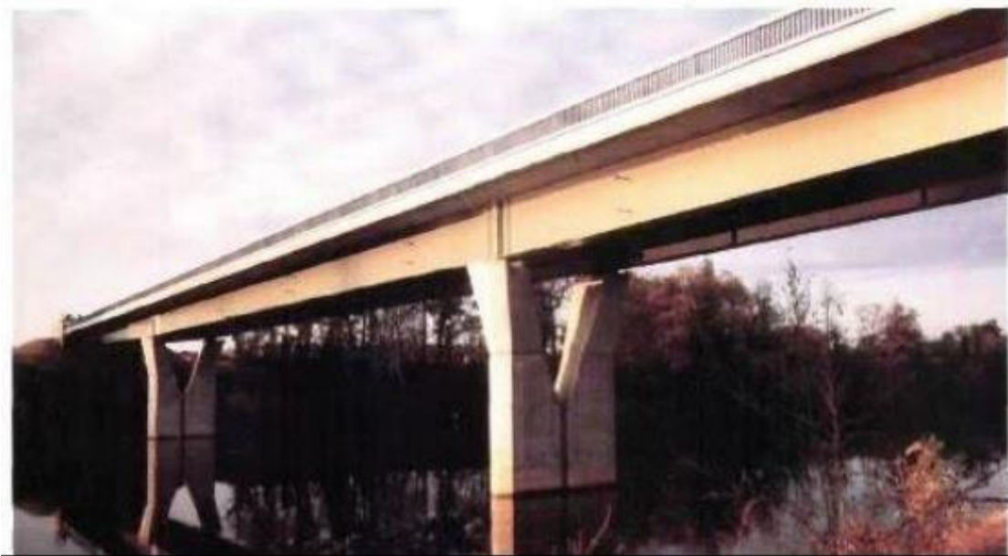
Figure II-5 : Pont mixte (bipoutre métallique à entretoises)
