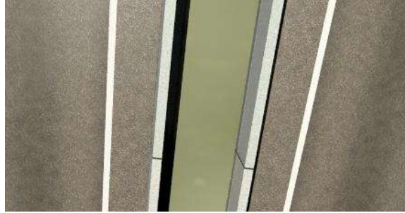
Figure 1-2: Eléments du terre-plein central
