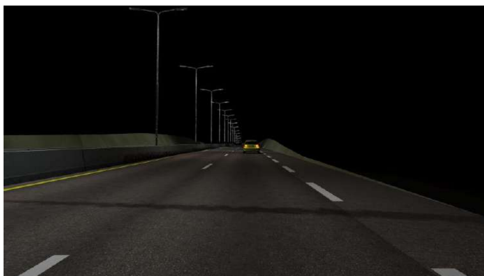
Figure 1-4: Visibilité sur le couloir de la route
