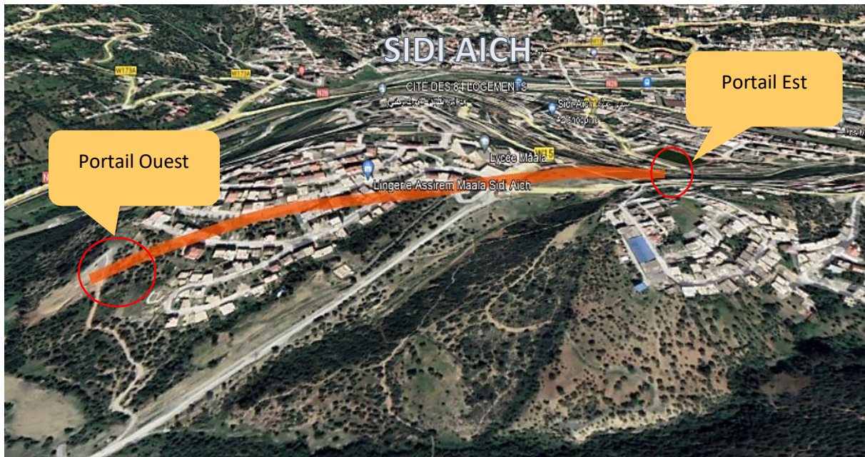
Figure III.2 : Photo satellitaire montrant la situation du tunnel de SIDI AICH.
