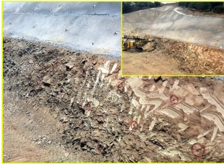
Figure IV.1 : Terrain observé sur la zone du portail ouest
