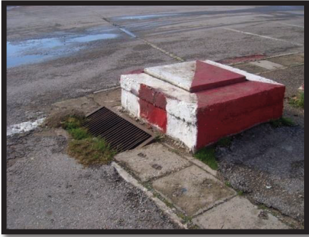
Réseau eaux pluviales
