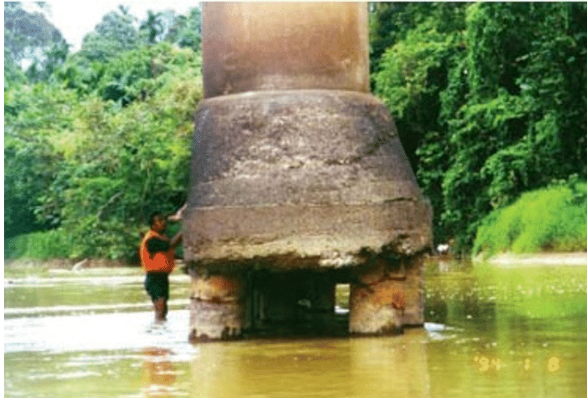
FIGURE IX.2 – L'affouillement-général-de-la-rivière-de-Sg-Jeniang-Kedah-27
