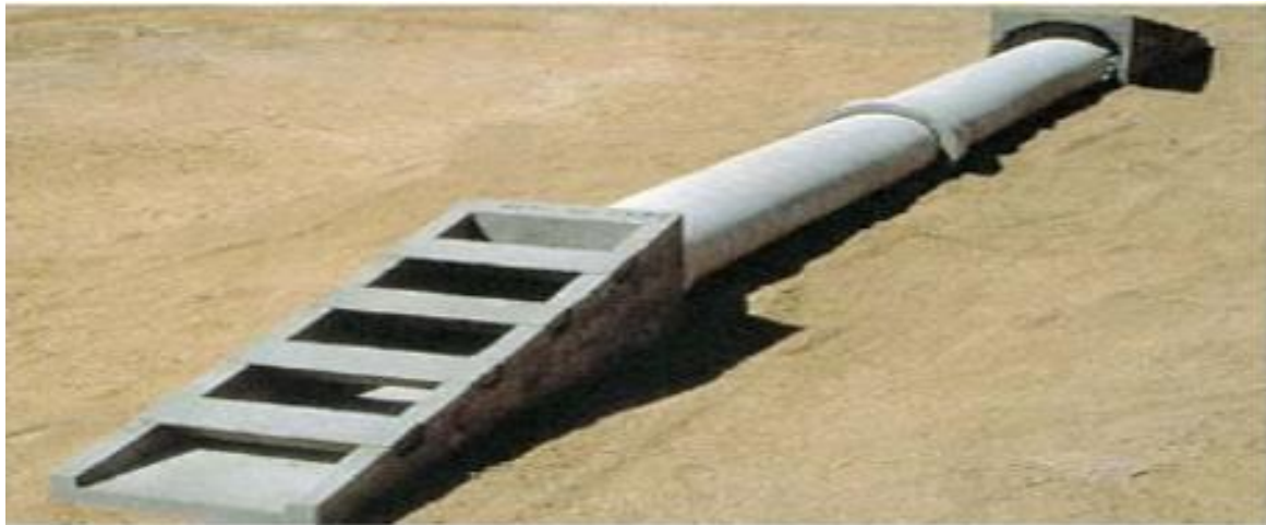
Figure IX-2 / Ouvrage d'assainissement transversal
