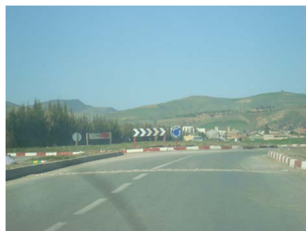
Récupération du tracé existant jusqu'au 2 ème giratoire
