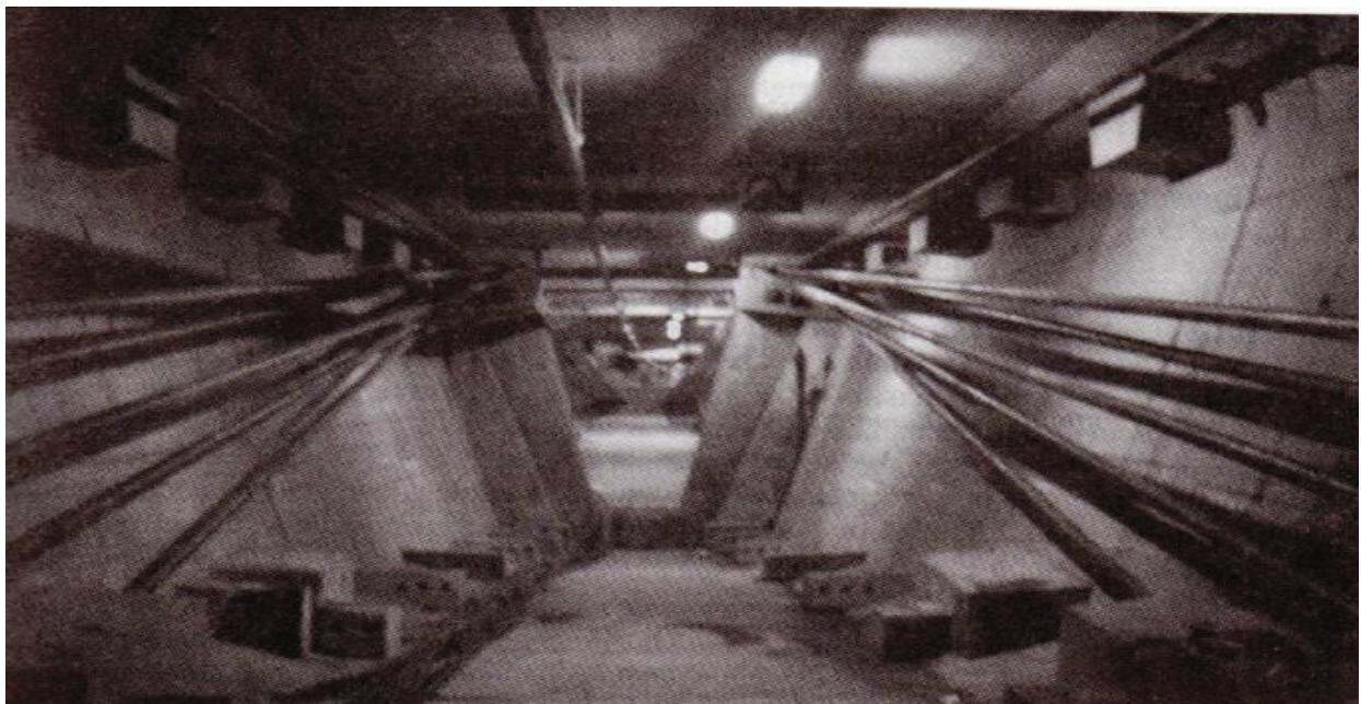
Figure I. 8 : Pont de l'île de Ré. Câblage de continuité extérieur
