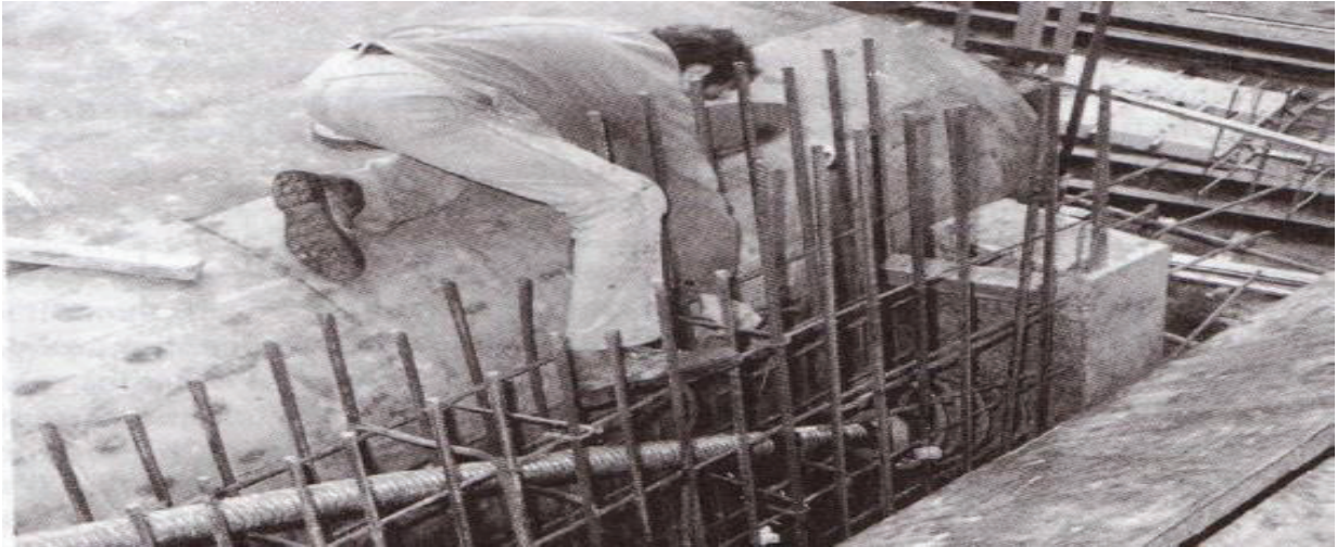
Figure I. 4 : Pont d'Amboise sur la Loire - Câble "descendant" dans une âme.
