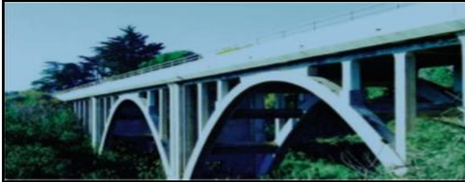
Figure I.24: Pont d'Arroyo Quemado (Californie)[15]
