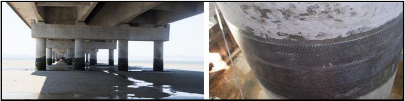
Figure I.22 : Réhabilitation et renforcement du pont de Vasco De Gama-Lisbonne[13]
