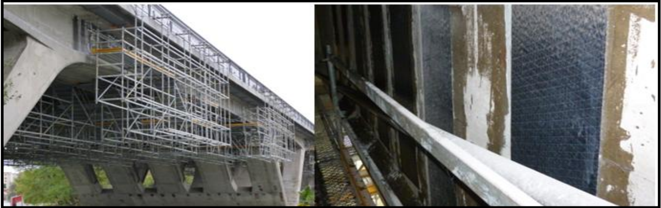
Figure I.20 : Réhabilitation et renforcement du pont de Saint-Michel-Toulouse[12]
