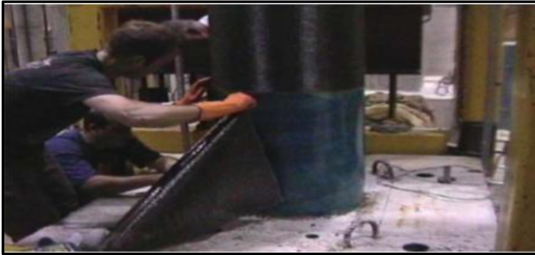
Figure I.9. Renforcement avec plaques en FRP[5]
