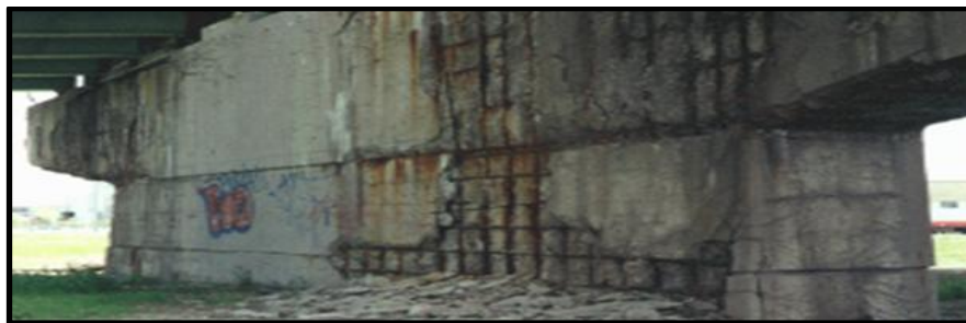
Figure I.5. Agression du béton par activité des chlorures.[2]
