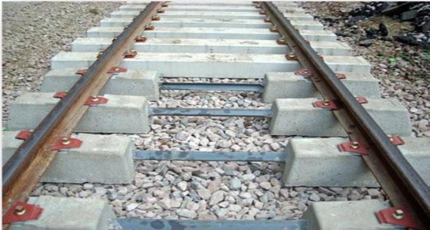
Figure III 4, Traverse en BA
