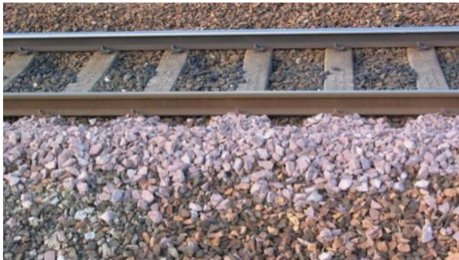
Figure VII, 2, Rails et traverses sur Ballast,
