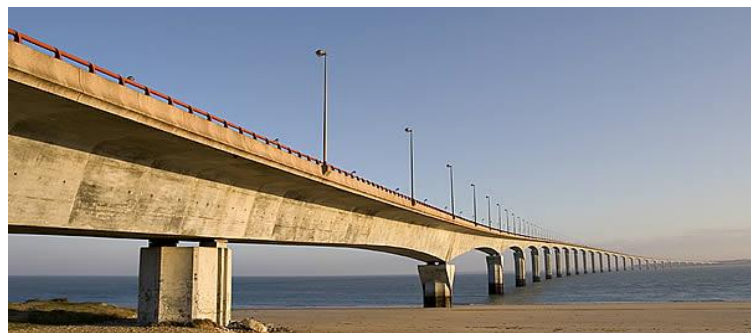
Figure IX. 2: Pont à poutre en caisson
