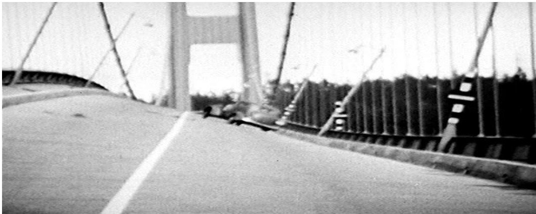
Figure IX.7: Mode de torsion du Pont de Tacoma.
