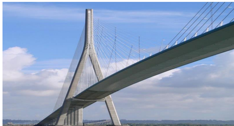
Figure IX. 5: Pont à haubans
