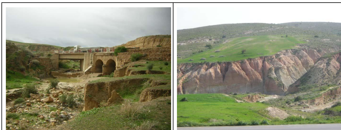
Figure I.9 : Vues générales de l'Oued Khrouf, montrent les talus excavés au pied des versants.
