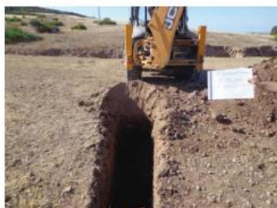
FigureV.1: vue de l'excavatrice à fouille
