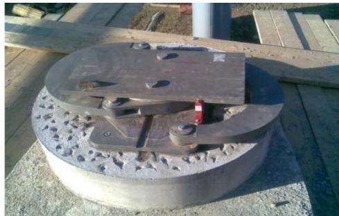
Fig : Retenue antisismique transversales sur pile
