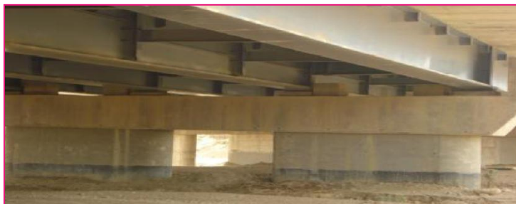
Fig: Disposition des plots parasismiques
