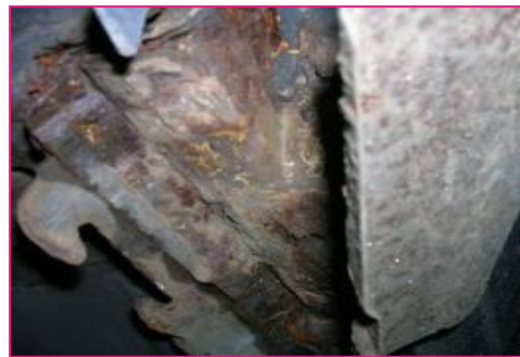
Fig : Images illustrant les désordres causés par la corrosion.
