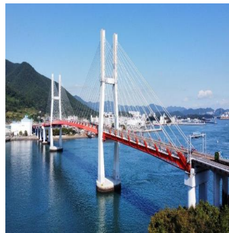
Figure VIII. 4:Pont à haubans de Harbin, Chine [33].
