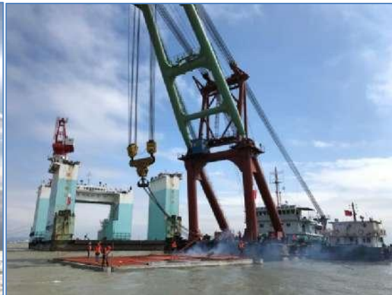
Positionnement et pose de caisson
