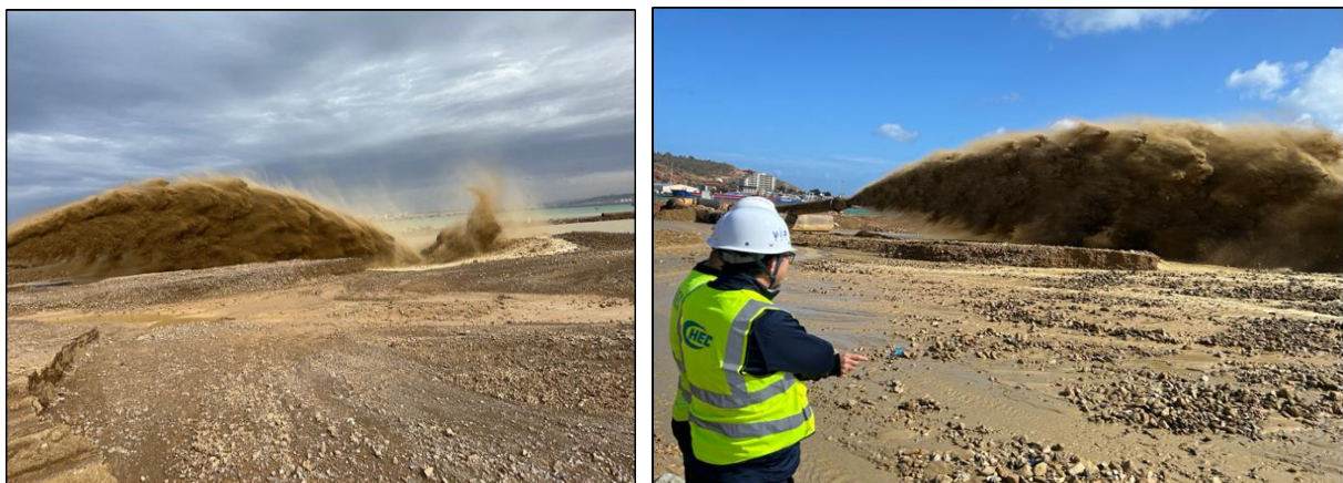
Figures IV.3 – Photos de la zone de refoulement
