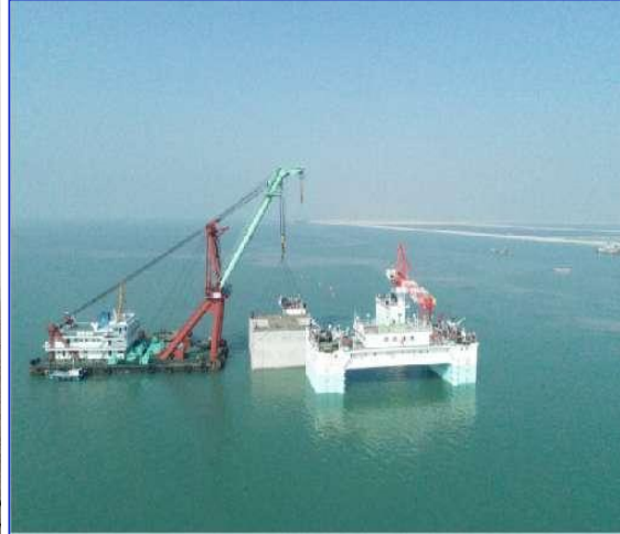
Submersion et déchargement
