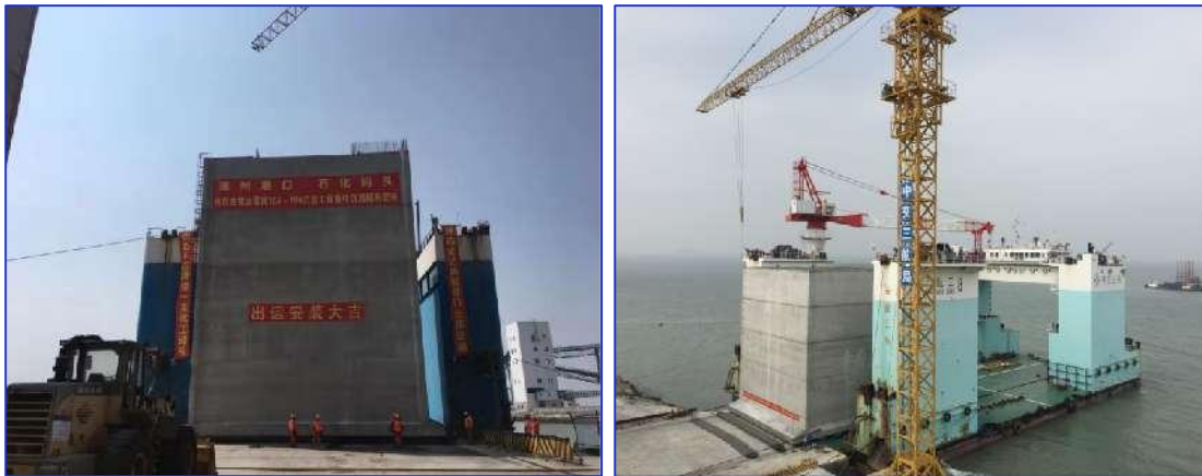
L'opération d'embarquement de caissons
