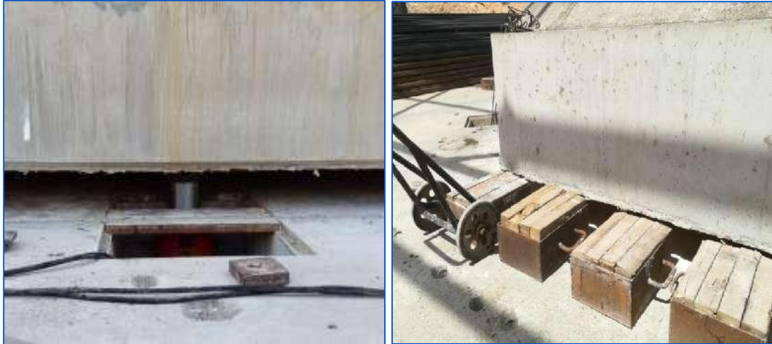
Schéma de procédure du soulèvement de caissons
