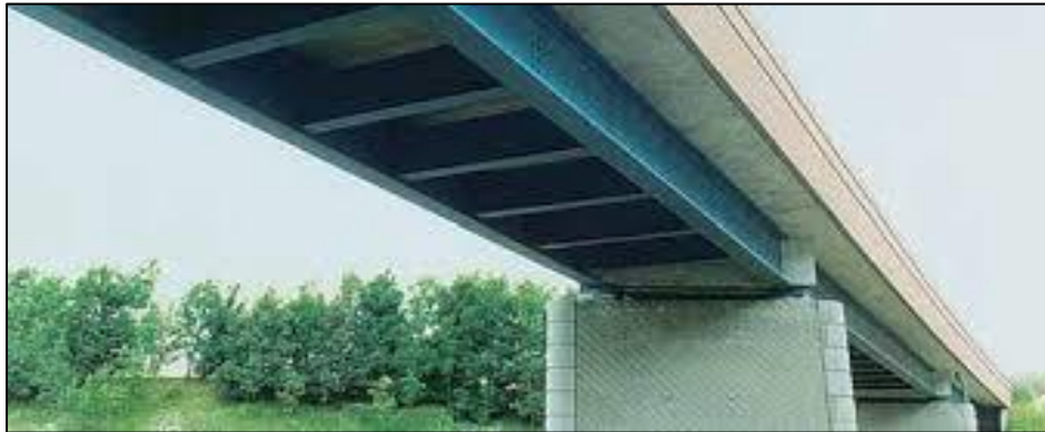
Figure II.3-6: Pont mixte Bipoutre
