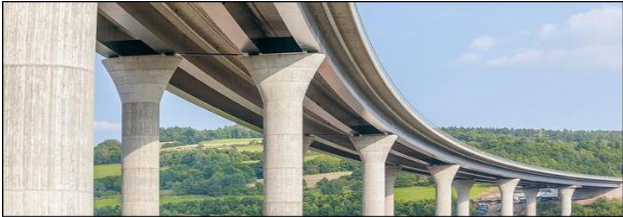
Figure II.3-1: Pont à poutres précontraintes (VIPP)
