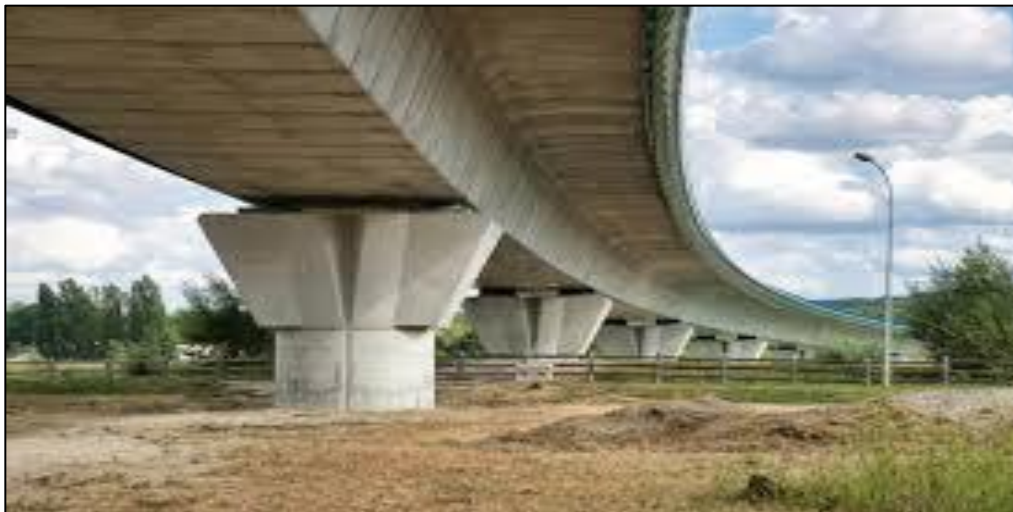
Figure II.3-3: Pont voussoir en béton précontraint
