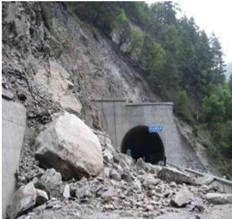
Figure I.7: Exemples de mécanismes de rupture au niveau des portails (Rock fall at the entrance of Zagunao Tunnel, Wang et al., 2009)
