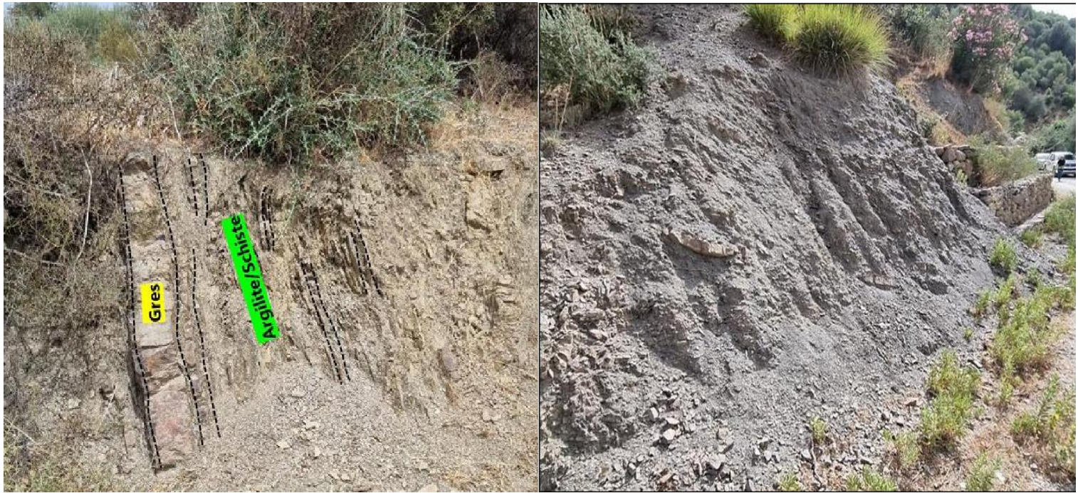
Figure III.34: Terrain observé au niveau du portail Sud (alternance grès argilite schisteuse).
