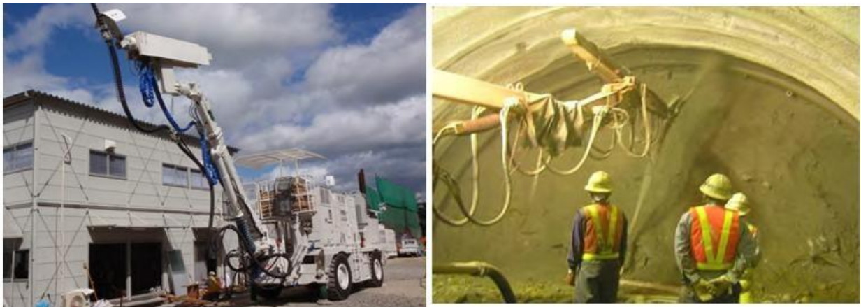
Figure I.15: Machine à projeter le béton (à gauche) et projection de béton (voie humide, à droite). (Source : projet JICA ).
