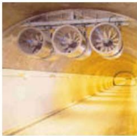
Figure V.60: Implantation de ventilateurs en voûte de tunnel (Source : dossier pilote des tunnels équipements section 4.1 Ventilation).
