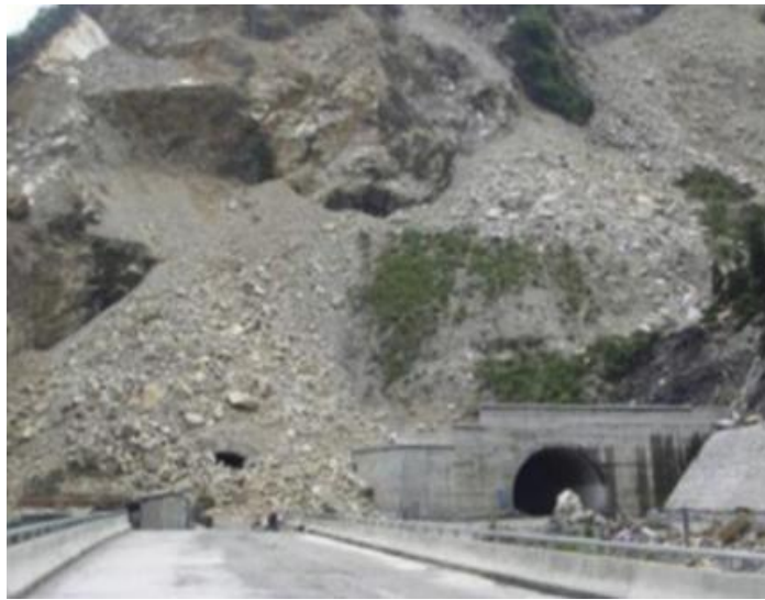
Figure I.11 : Classification des dommages sismiques Effondrement par rupture de pente (Li 2012)
