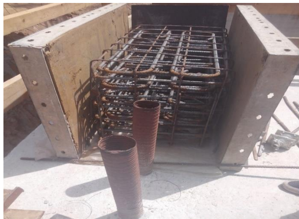
Figure VII. 7 : Ferrailage, coffrage et coulage des cales provisoires.
