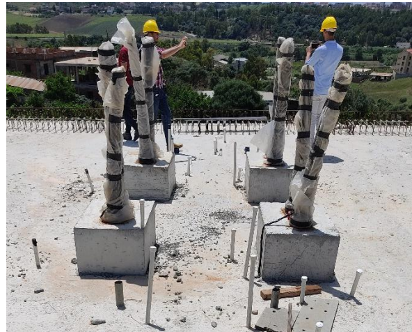
Figure VII. 6 : Ancrages supérieures des câbles de clouage.
