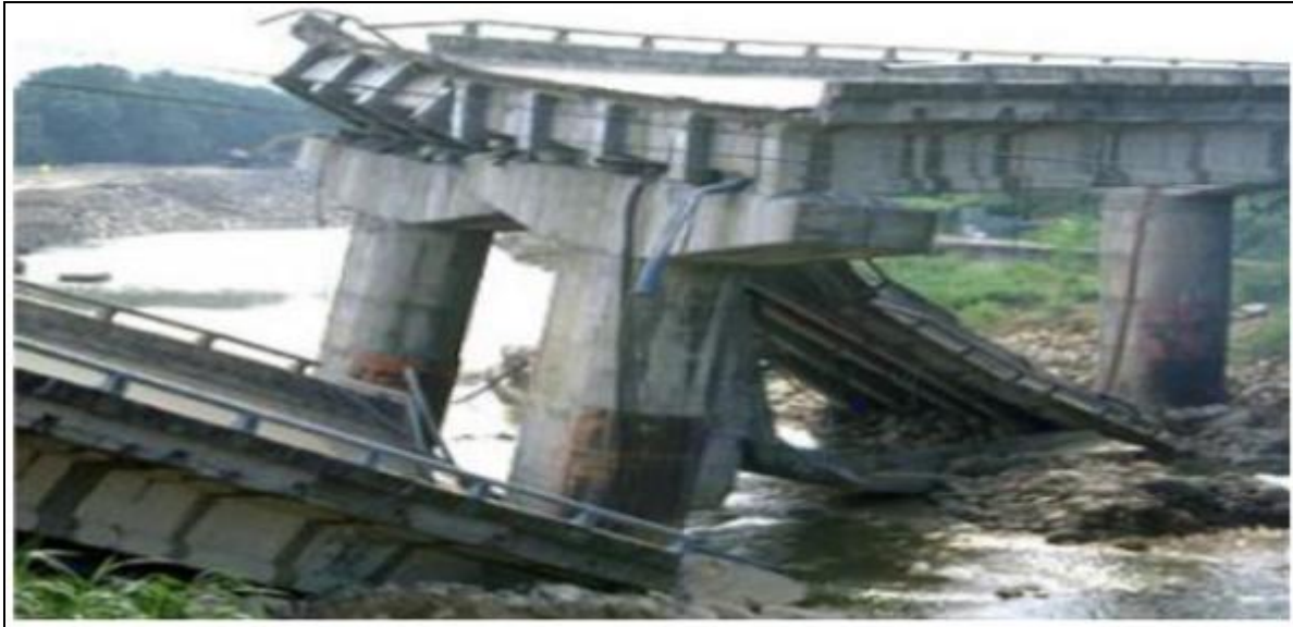
Figure XI. 3 Effondrement du tablier d'un pont à poutres préfabriquées lors du tremblement de terre de Taiwan en 1999.
