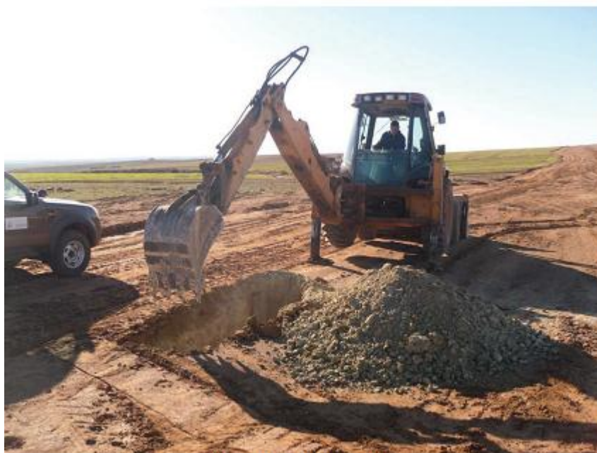
Excavation du puits
