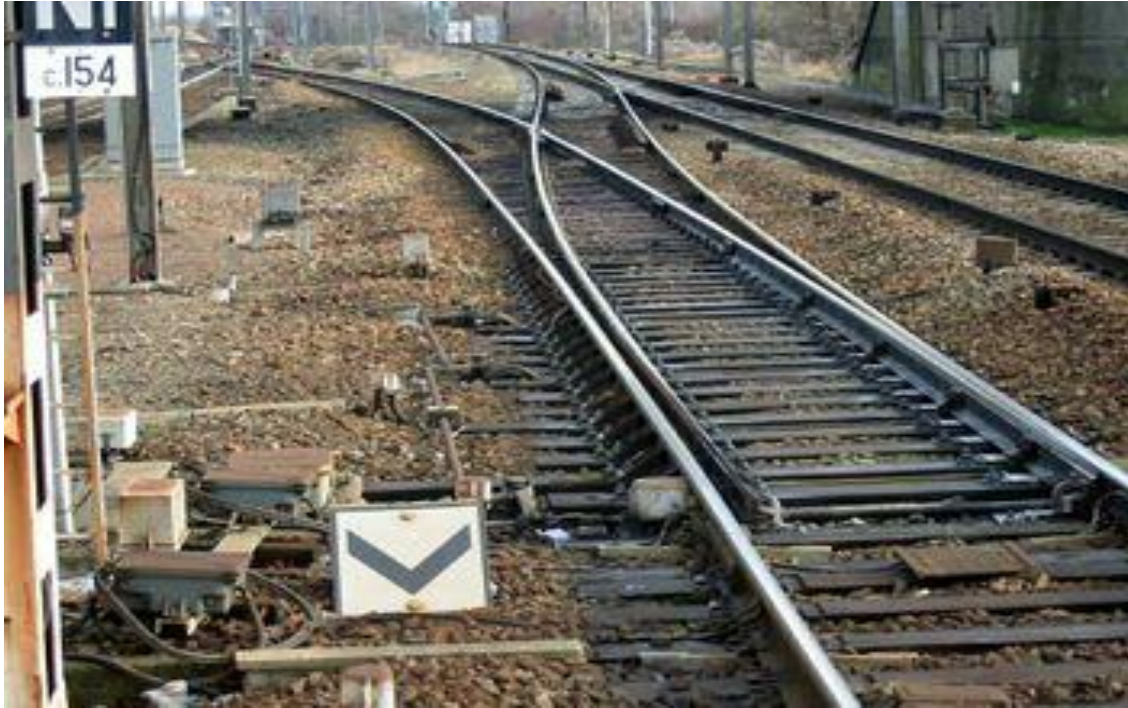
Figure n°2 : une appaillage de voie
