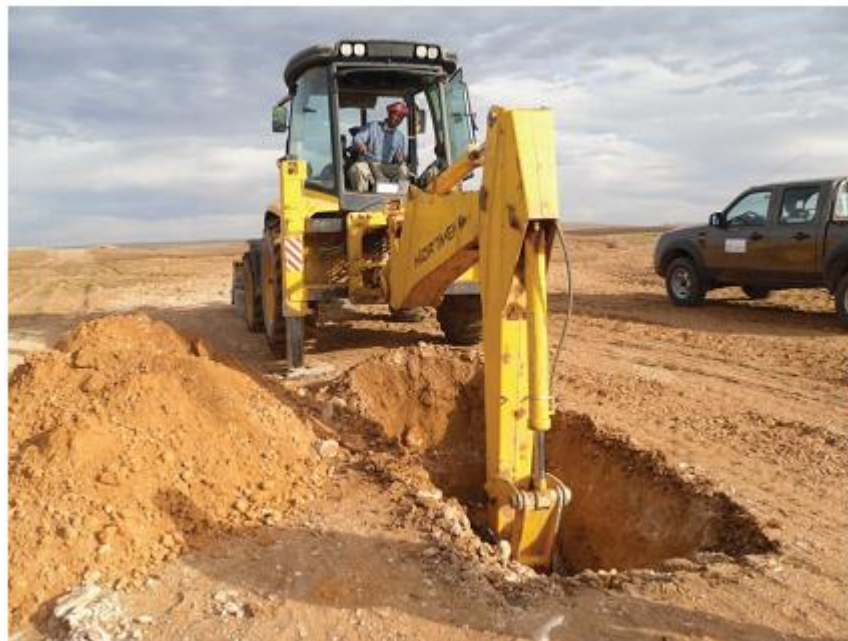
Excavation du puits
