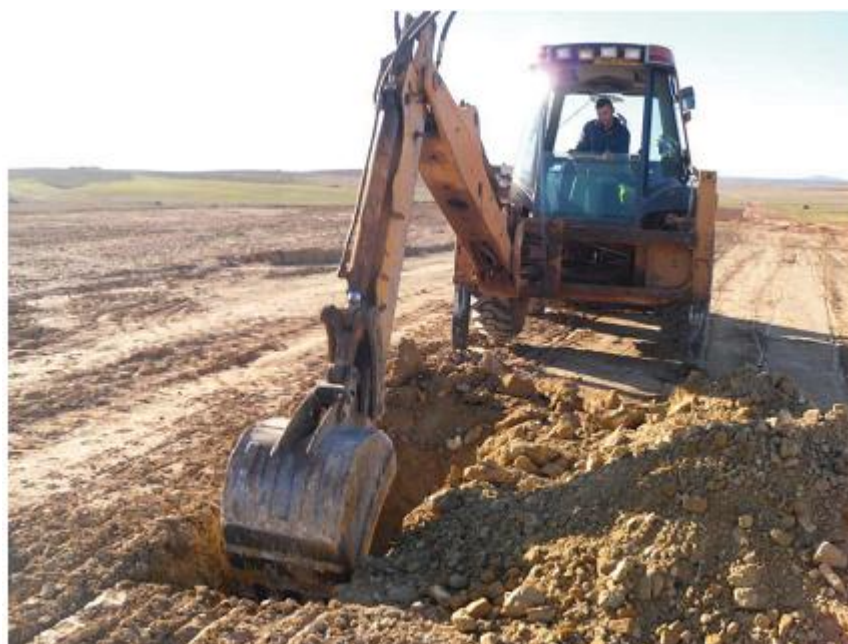
Excavation du puits
