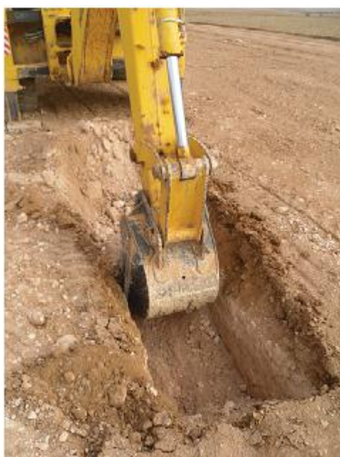
Excavation du puits 2
