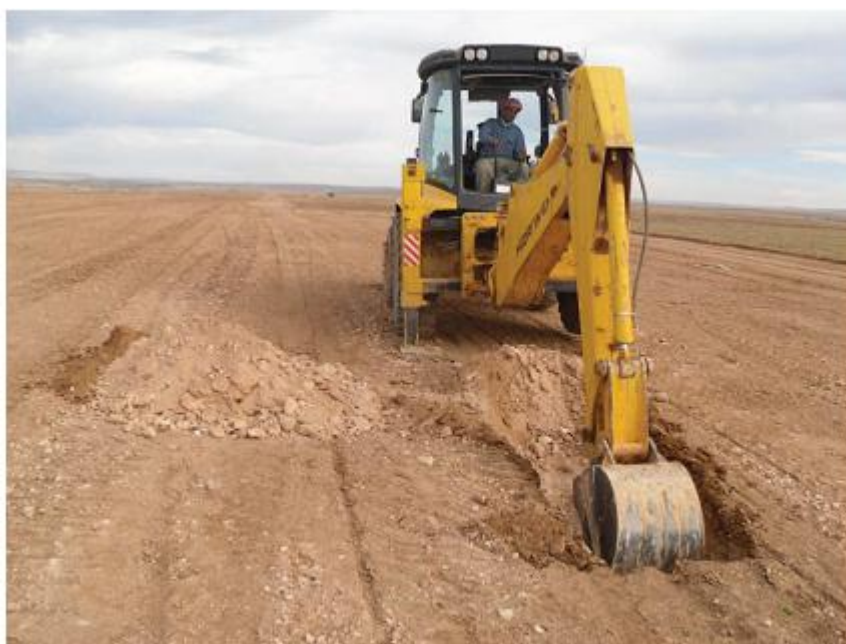
Excavation du puits 1
