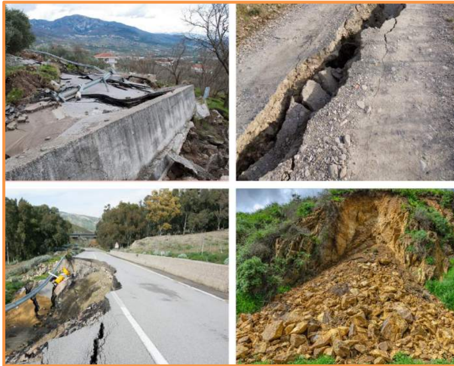
Figure 1 : Exemples du glissement des routes
