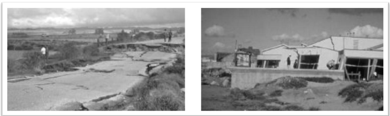
Figure 1.6 : Epandage latéral le long de la route Sandholdt (à gauche) et destruction d'un centre de recherche (à droite) à Moss Landing. (D'après le Earthquake Engineering Research Center, University of California, Berkeley; Elgamal et al, 2001)
