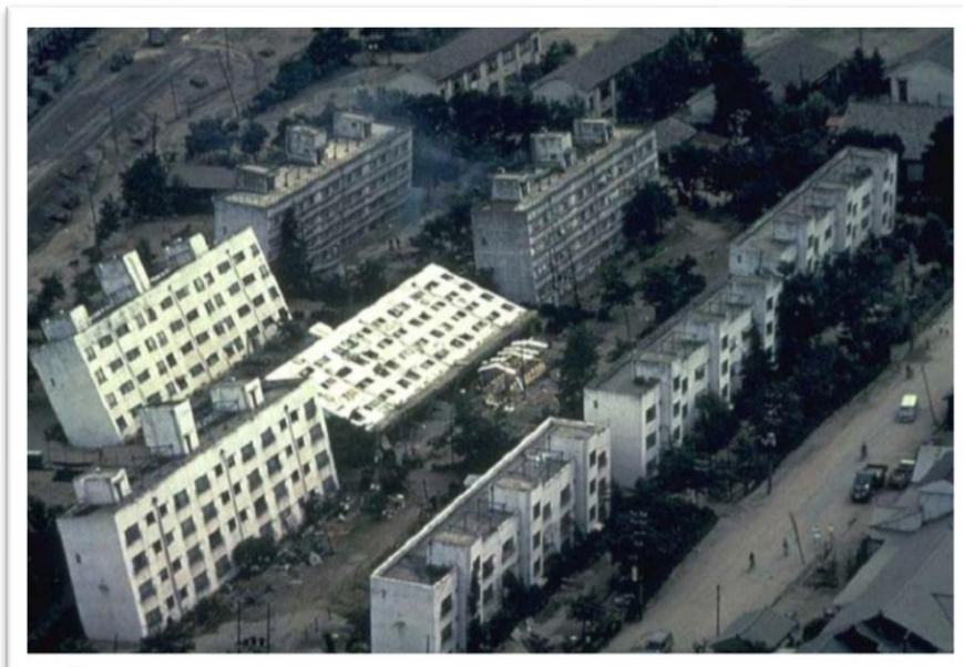
Figure 1.4 : Inclinaison des bâtiments d'appartements de Kawagishi-cho à Niigata au Japon dues à la chute de la capacité portante du sol par liquéfaction (d'après Peter M. Byrne et al, 2008)
