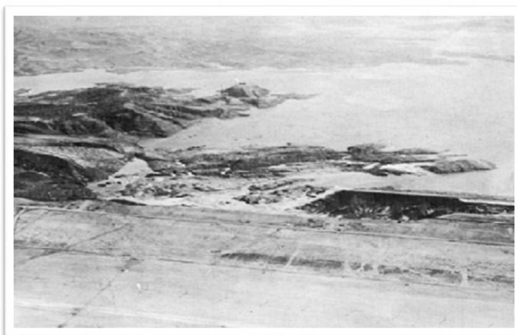
Figure 1.3 : Vue aérienne de la rupture de barrage de Fort Peck (corps de l'armée des États-Unis d'Ingénieurs, 1939, d'après Mike Jefferies et Ken Been, 2006)
