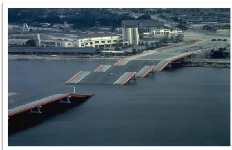
Figure 1.5 : Rupture du pont de Showa, à Niigata au Japon, dues à l'épandage latéral dans le sol (d'après Pet M. Byrne et al, 2008)
