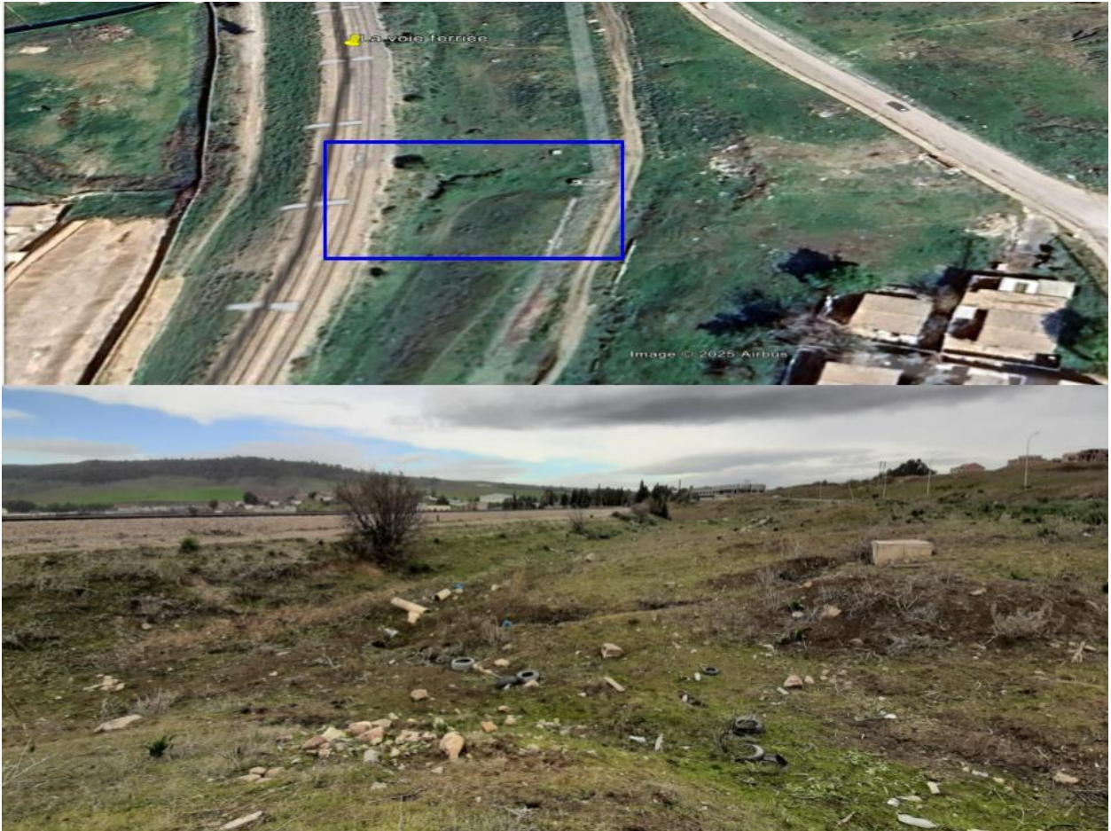
Figure I-17: Le glissement actif peut endommager l'infrastructure ferroviaire
