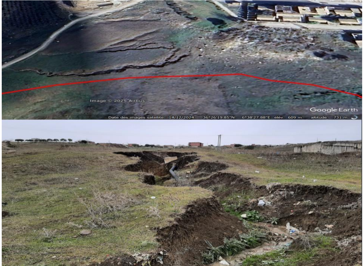
Figure I-9:Cote aval du glissement (36°26'18.63"N 6°38'22.90"E)
