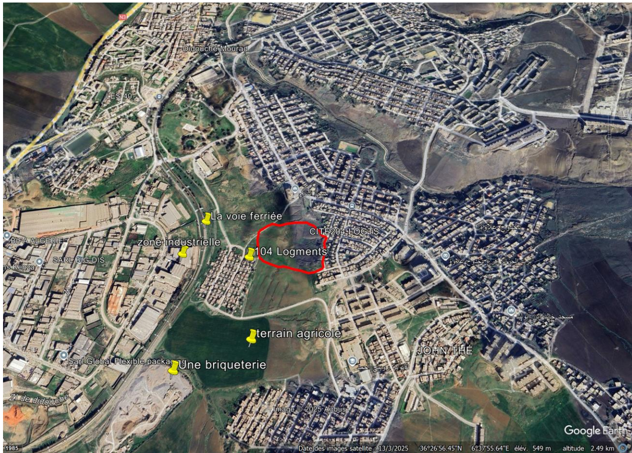
Figure II-1:Vue satellite du site glissement.
