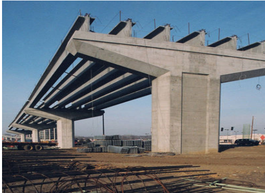
Figure I.4 : Pont à poutres
