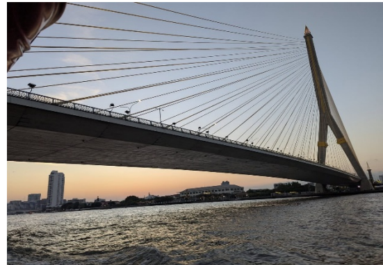
Figure I.5 : Pont à haubans
