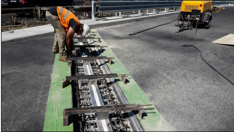
Figure VIII.7: Joint de chaussée.
