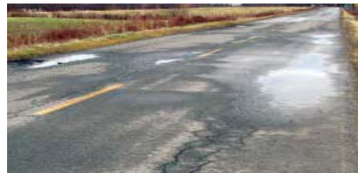
Figure X .48 : Affaissement
