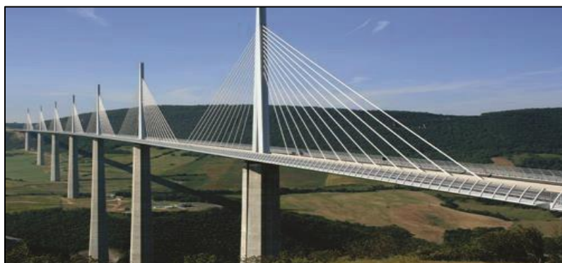
Figure I.13: Pont à haubans.
