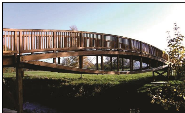
Figure I.2 : Pont en bois.
