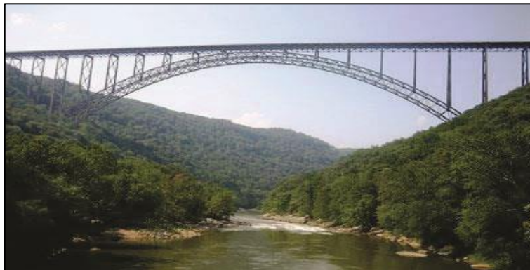
Figure I.15: Pont en arc.
