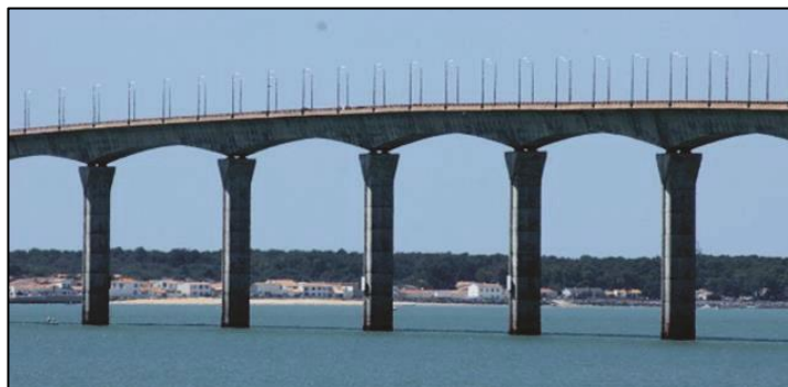
Figure I.11: Pont en poutre-caisson.
