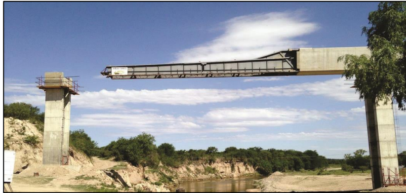
Figure I.18: Poussage du tablier.
