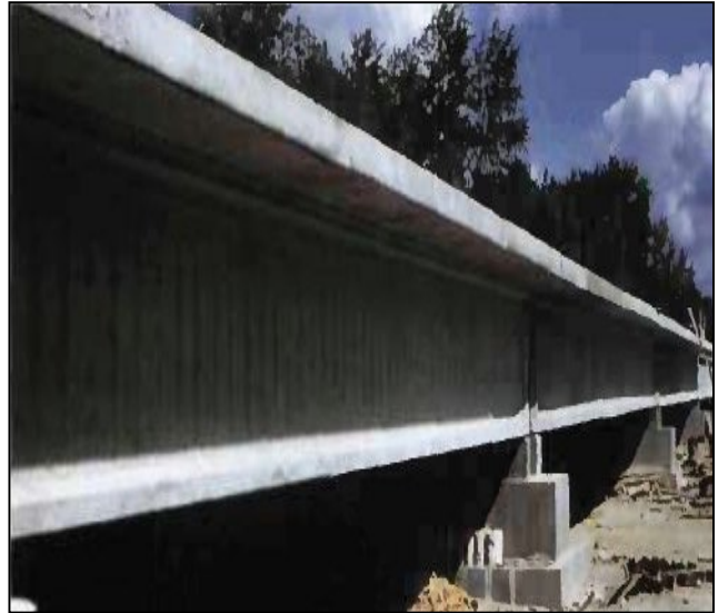
Figure N°3: pont à poutre en béton précontraint
