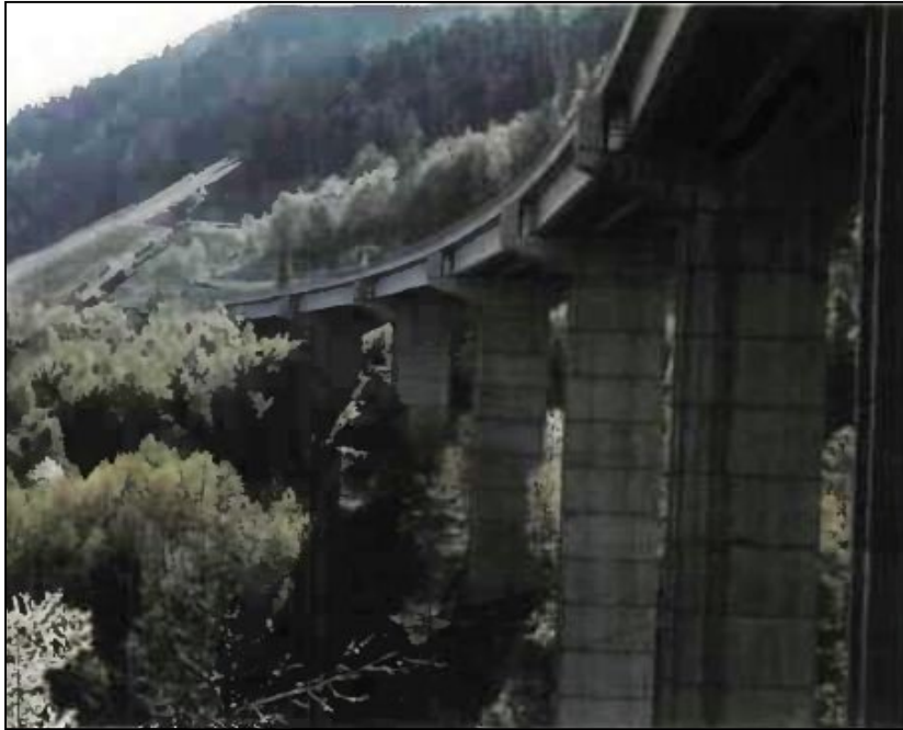
Figure N°4 : pont courbe en béton précontraint
