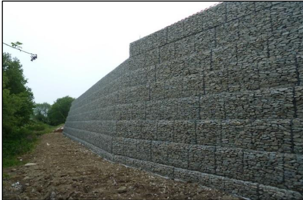
Figure I-22 : ouvrage souple (mur en gabions)
