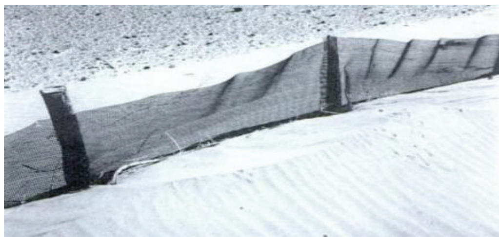
Figure I.7 : L'utilisation de grillage synthétique.
