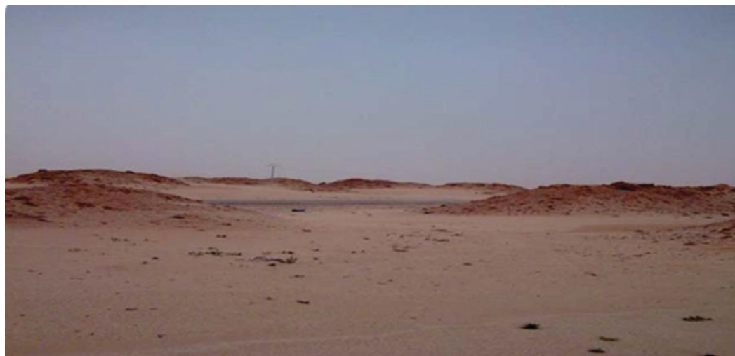
Figure I.15 : Exemple d'application du dispositif de Dras perpendiculaire au vent dominant (route Touggourt-Djelfa)
