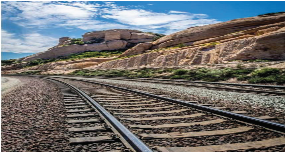
Figure IV.1 : une voie ballastée
