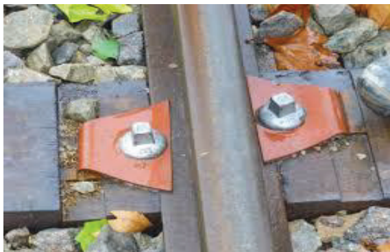
IV.15 : Les attache utilisé dans notre projet.
