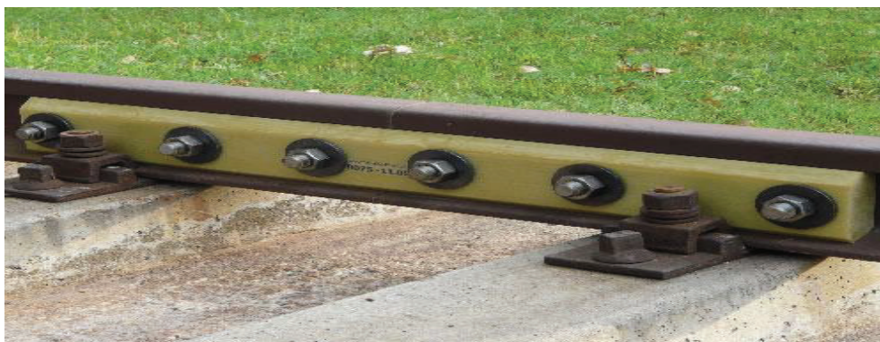
Figure IV.8 : Assemblage par éclissage
