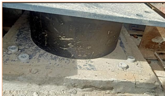
Figure VII. 1: Appareil d'appui type HDRB
