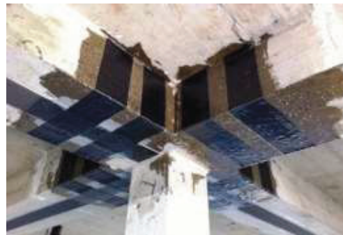
Figure I.4-Renforcement par stratification au contact avec FRP carbone [9]
