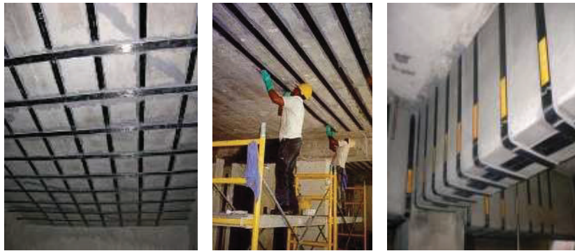
Figure I.3- Renforcement par plats consolidés à fibres de carbone [3]
