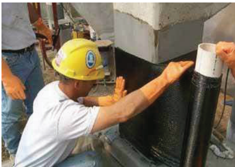
Figure I.4-Renforcement par stratification au contact avec FRP carbone [9]
