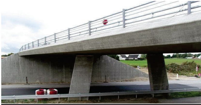
Figure I.5 : Pont en béton arme.
