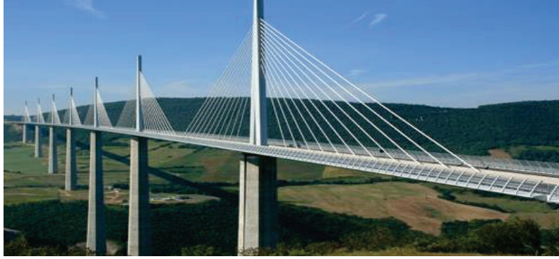
Figure I.13: Pont à haubans.
