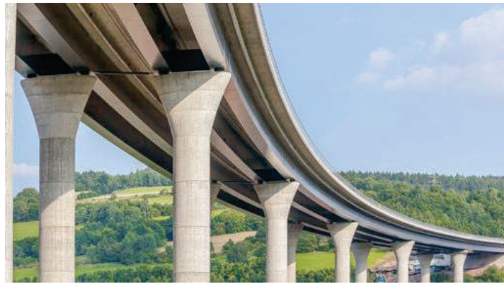
Figure I.6 : Pont en béton précontrainte.
