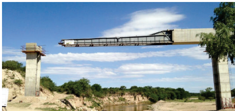
Figure I.18: Poussage du tablier.
