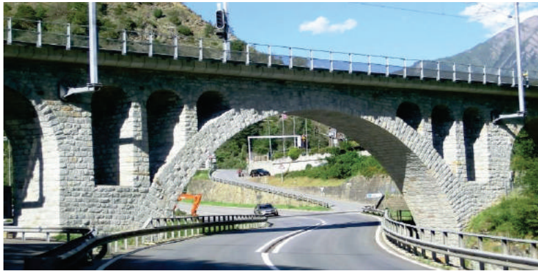
Figure I.3 : Pont en maçonnerie.
