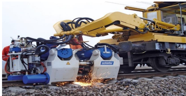
Figure I-7 Machine de soudage des rails par étincelage
