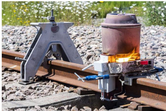
Figure I-6 Le soudage aluminothermique
