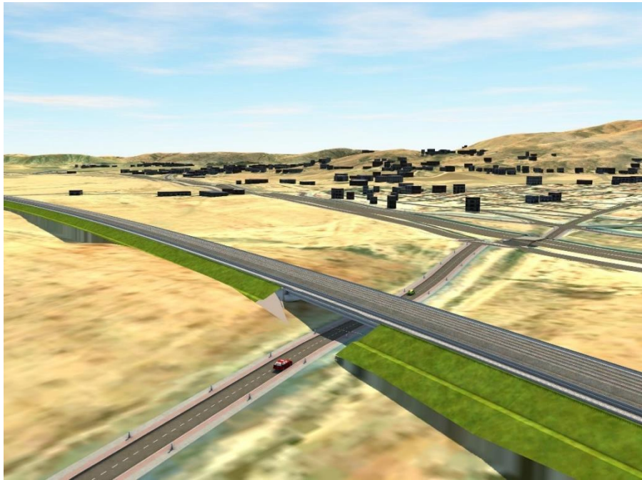
Figure IX-5 : Rétablissement routier (pont cadre)
