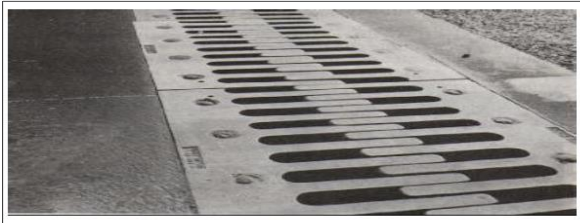
Figure VIII. 5 : Joint de chaussée.
