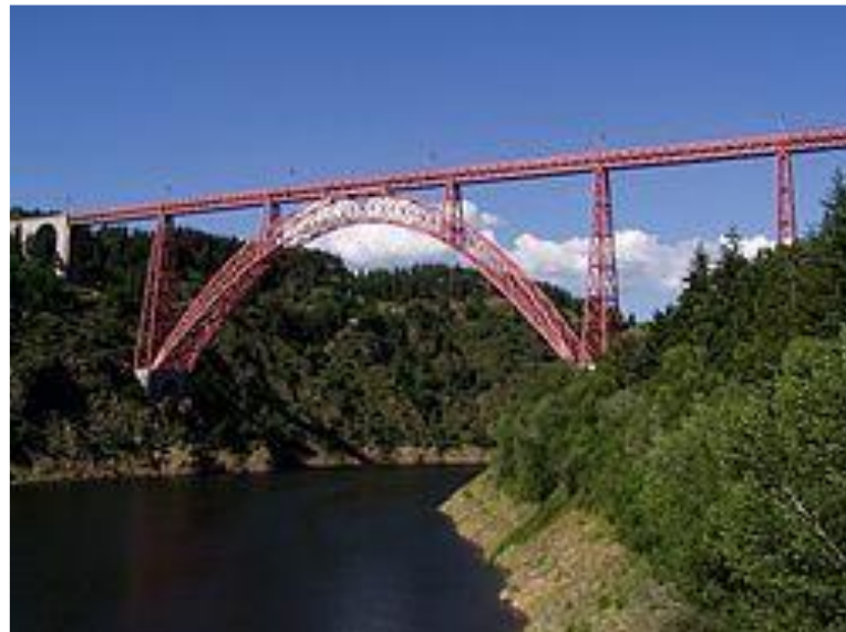
Figure I. 5 : pont métallique Viaduc de Garabit.
