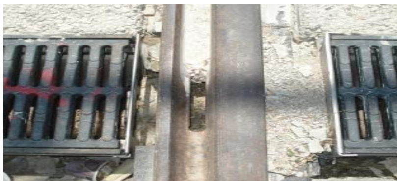
Figure VIII. 6 Ouverture dans le fond de la gorge du rail. [2]
