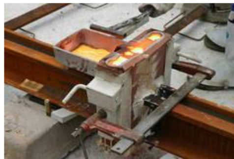
Figure IX. 7 Soudure des rails par coulage du métal en fusion dans le moule. [2]
