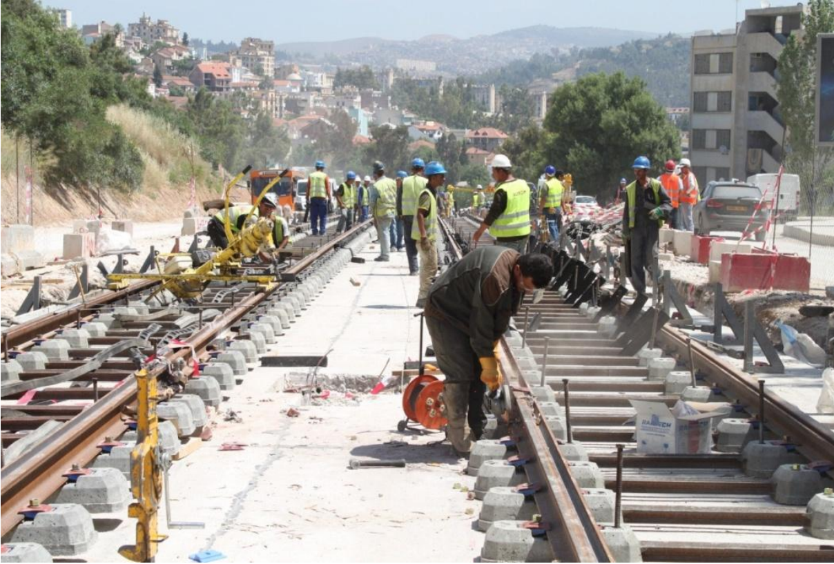
Figure 1. Pose de voie, ligne 1, tramway de Constantine
