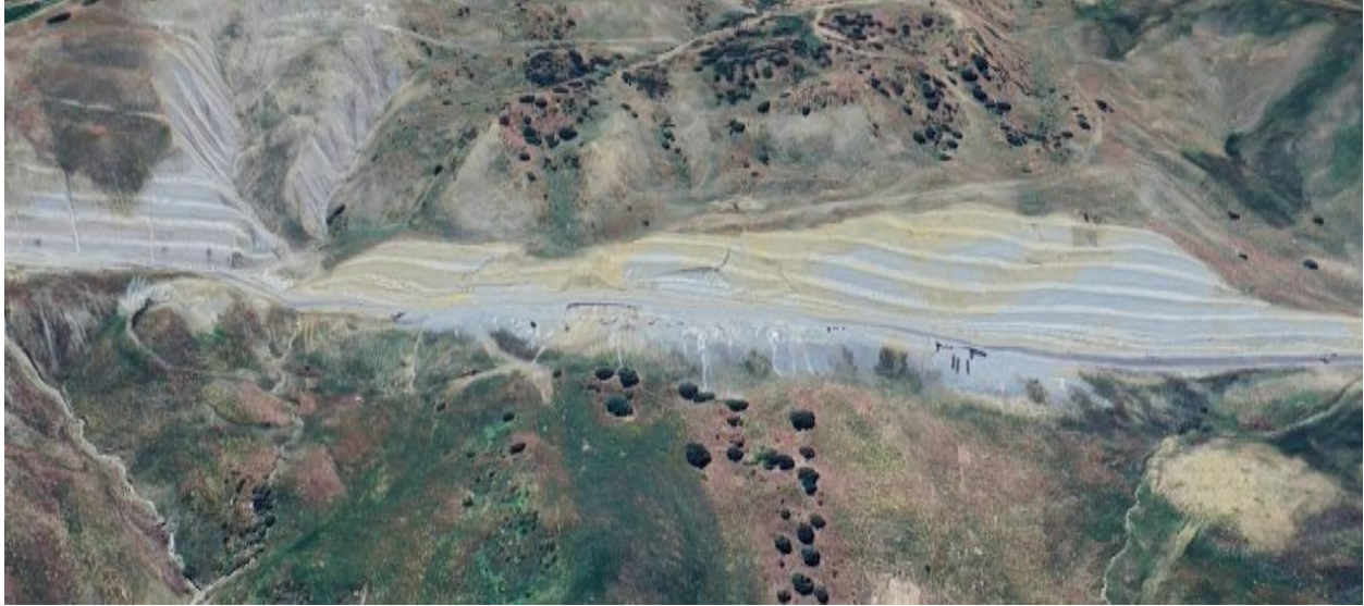
Figure III.1: Vue satellite de la zone du glissement du terrain
