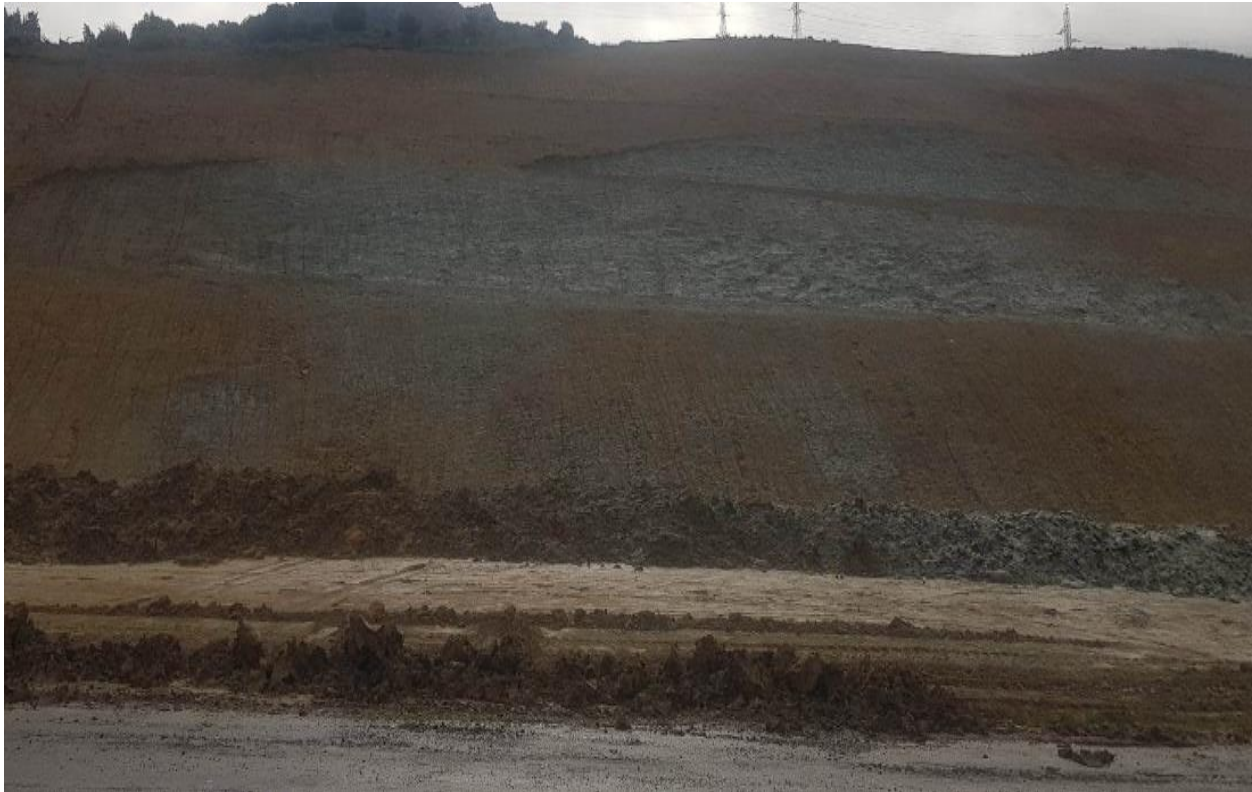
Figure III.2: Vue en élévation du talus
