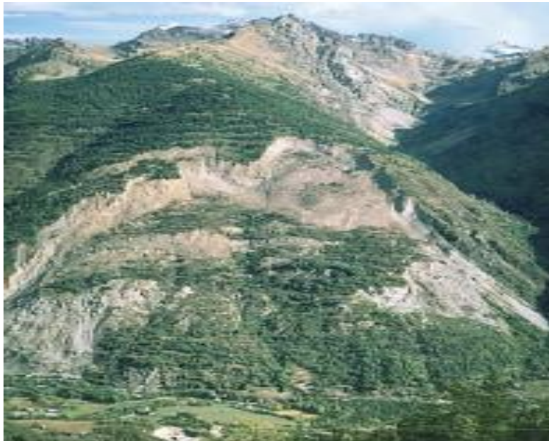
Figure I.1: Glissement de La Clapière (Alpes Maritimes)
