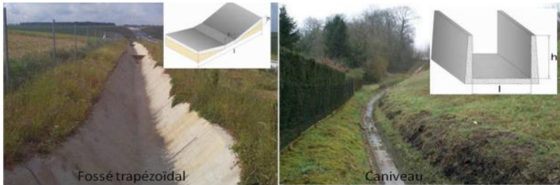
Figure I.14: Exemple d'ouvrage d'assainissement
