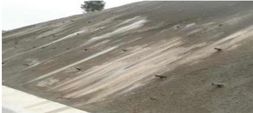
Figure I.19:Exemple de drains subhorizontaux
