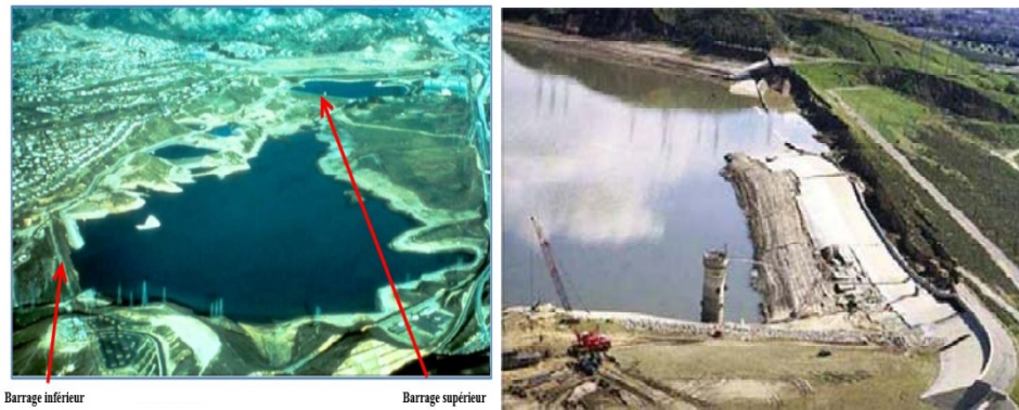
Fig 1.20: Barrage inférieur de San Fernando après le séisme de 1971 (Handra, 2009).
