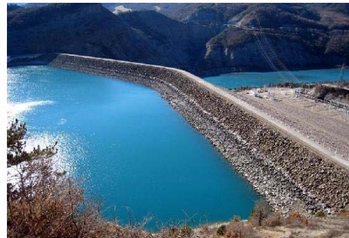
(a) Schématisation d'un barrage en terre zoné. (b) Barrage de Serre-Ponçon (France). Fig 1.10: Barrage en terre zoné.
