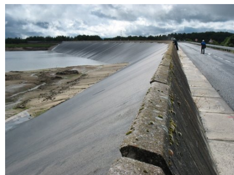
(a) Schématisation d'un barrage à masque amont (USBR, 1987). (b) Barrage de Monnes (CFBR, 2012). (masque en béton bitumineux)
