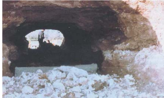
Fig 1.15: Renard dans un barrage (Lautrin, 2002).
