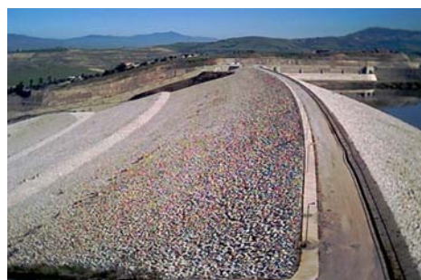
(b) Vue générale du barrage
