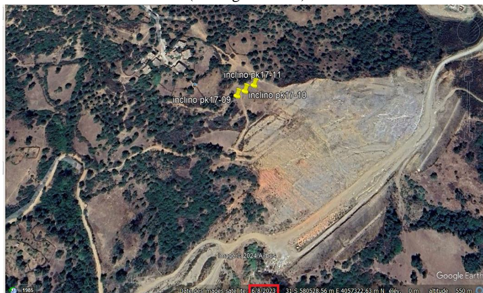
Figure 2-9: Vue de la zone du glissement du terrain actuellement (après glissement)
