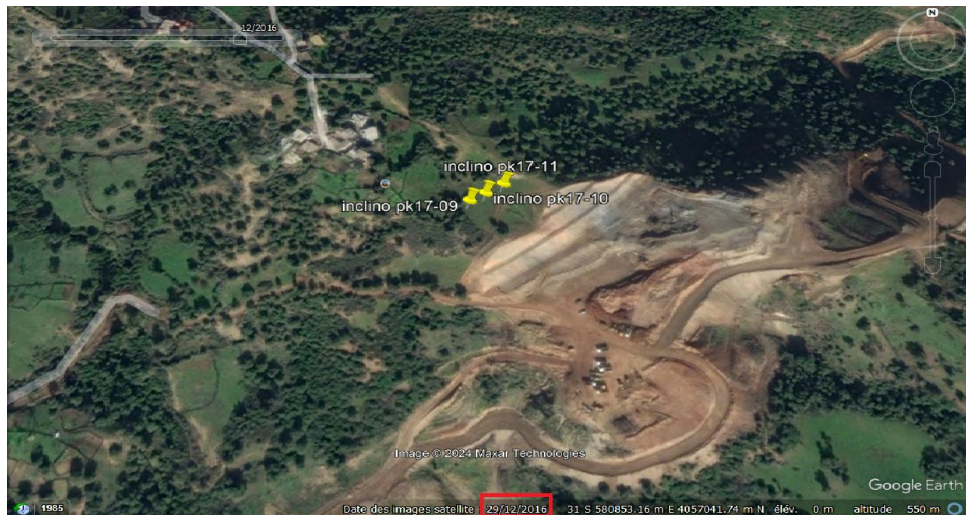
Figure 2-8: Vue de la zone du glissement du terrain au début des travaux du terrassement (avant glissement)
