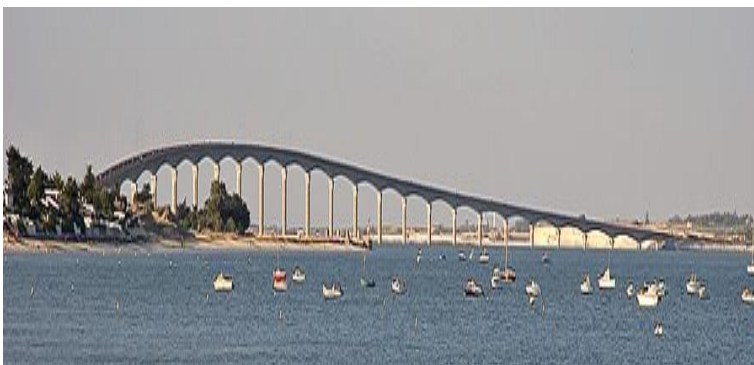
Figure I. 12. Pont de l'Île de Ré
