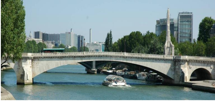
Figure I. 10. Pont de la Tournelle (Paris)
