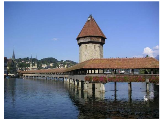
Figure I. 2. Le pont de la Chapelle à Lucerne
