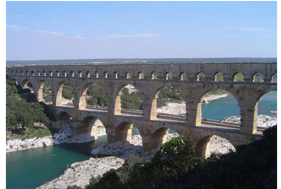
Figure I. 1. Le plus haut pont aqueduc connu du monde romain
