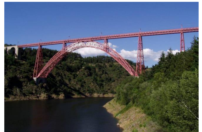
Figure I. 6. Pont viaduc de Garabit (Cantal), achevé en 1884, avec
