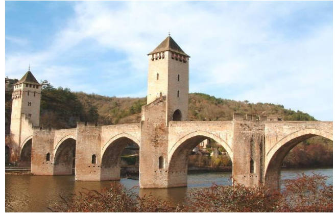
Figure I. 3. Cahors, pont Valentré achevé en 1378
