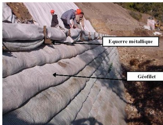
Figure 36 Talus renforcé par le géotextile
