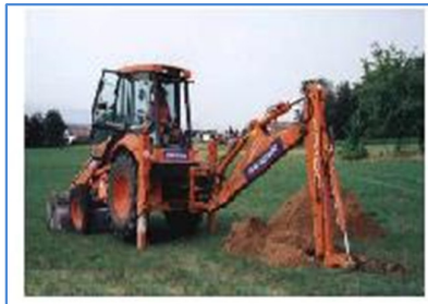
Figure 12 Exécution d'un puits [Source Google Image]
