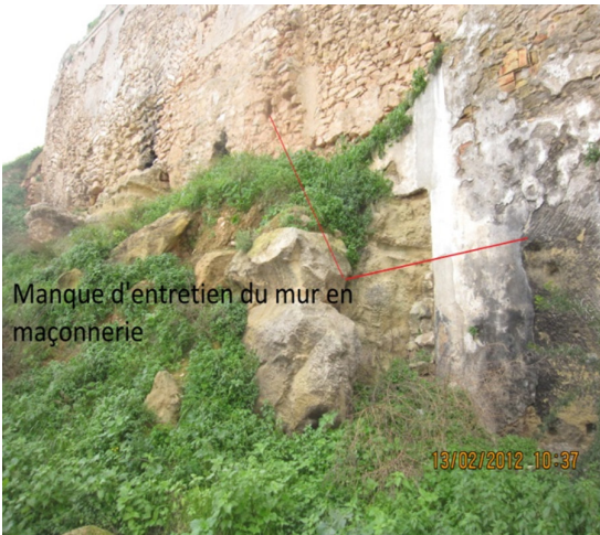
Figure 51 Mur en maçonnerie dans la rue des jardins
