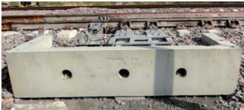
Figure IV. 3 : Muret pour ballast.
