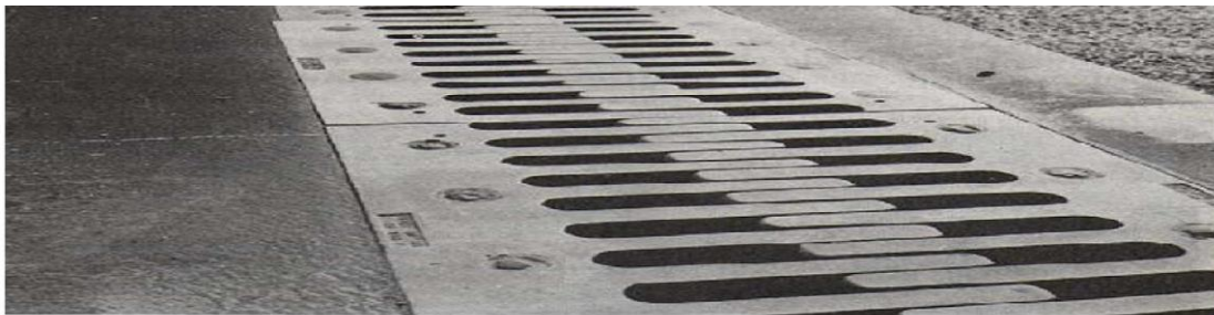
Figure IX. 5:joint de chaussée
