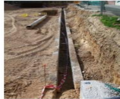
Figure 39: Exemple de Murettes-guide avec définition géométrique
