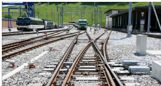
Figure N°III.04 : Appareil de Voie
